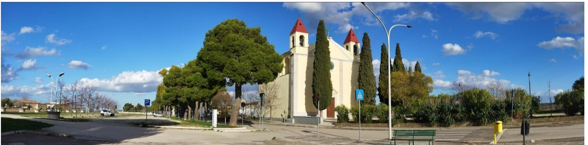
Figura 160: Rispettivamente foto (A) dello SDF, foto (B) con indicazioni impianti e foto (C) resa post operam da PV3: "Trinità"
