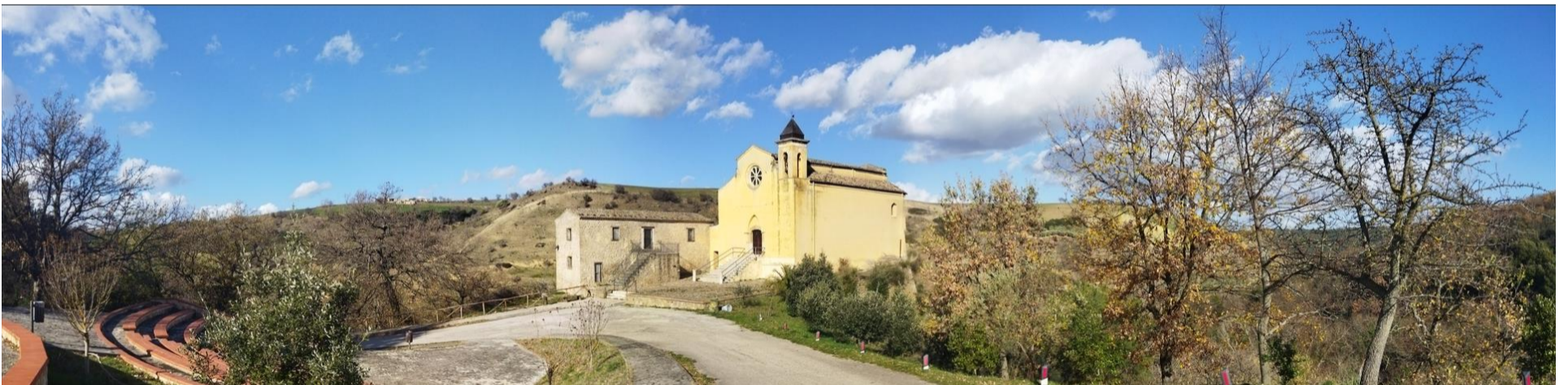
Figura 181: Rispettivamente foto (A) dello SDF, foto (B) con indicazioni impianti e foto (C) resa post operam da PV21: "Vallone Esca e S. Nicola inf. N. 580"
