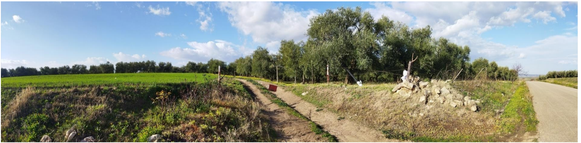
Figura 190: Rispettivamente foto (A) dello SDF, foto (B) con indicazioni impianti e foto (C) resa post operam da PV30: "Masseria Barbero (Segnalazione Architettonica)"
