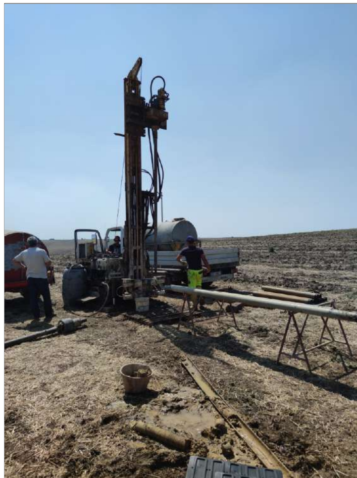
Postazione sondaggio WTG 9
