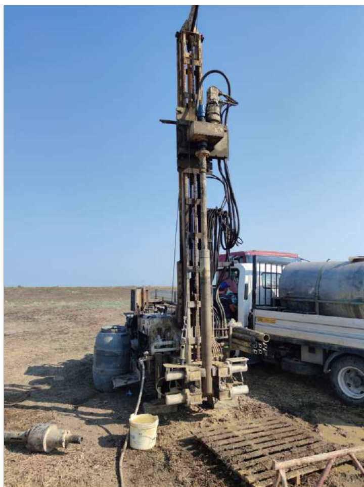
Postazione sondaggio WTG 12
