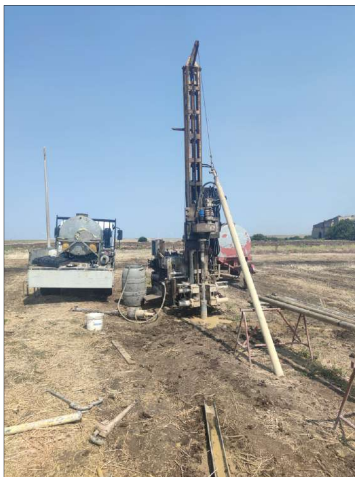
Postazione sondaggio WTG 6
