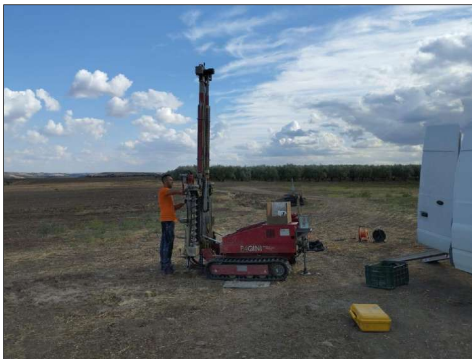
Foto Postazione Prova WTG12
