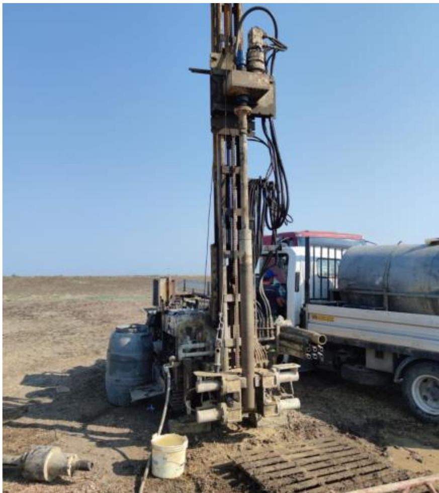
**Figura 30 – Sonda perforatrice CMV 420 Geo 305; fase di esecuzione sondaggi geognostici.**
