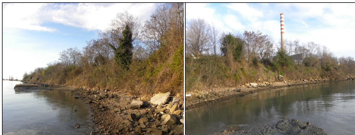
Tratto a mare dell'area oggetto di intervento
