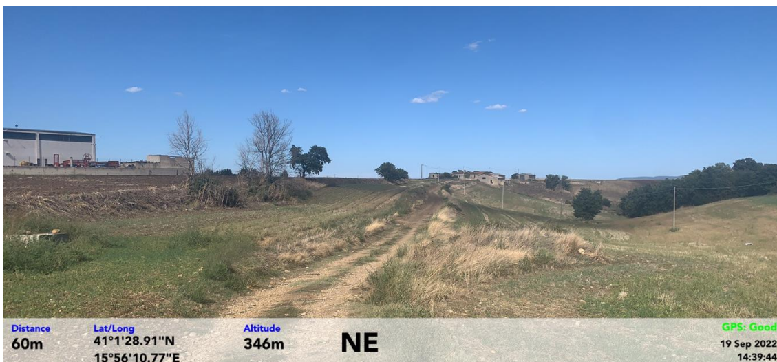
Figura 110 - Strada esistente da adeguare per raggiungere la torre 4 - Punto di scatto 4279
