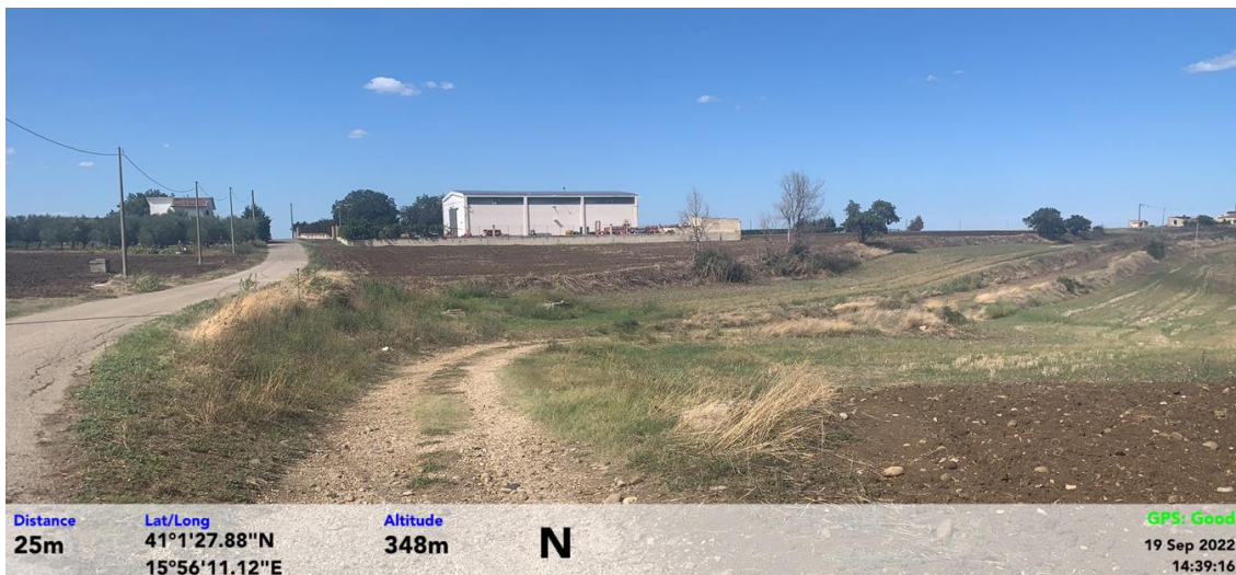
Figura 109 – Accesso alla strada esistente da adeguare per raggiungere la torre 4 - Punto di scatto 4278
