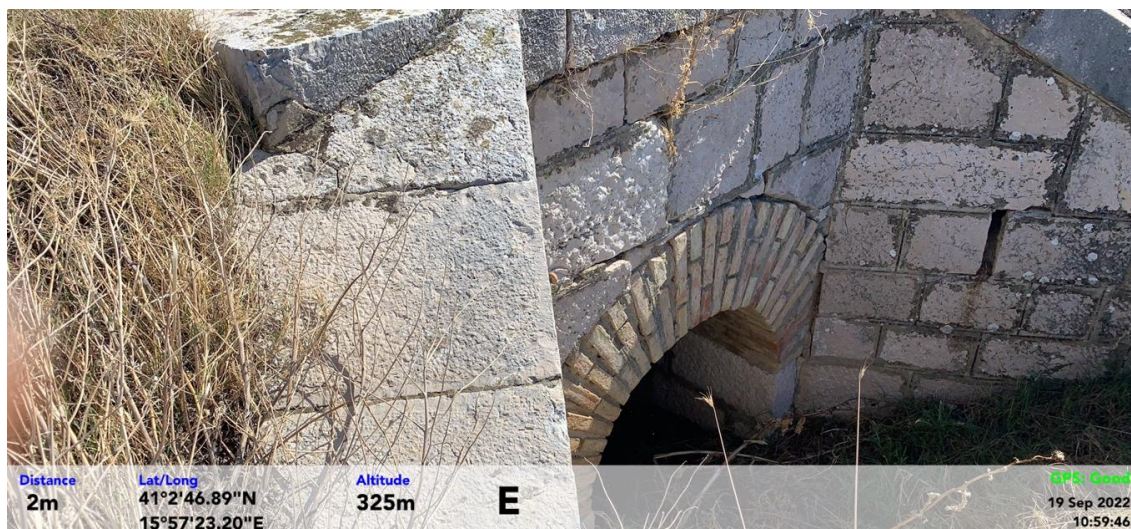
Figura 56 - Attraversamento stradale in corrispondenza del punto di scatto 4191
