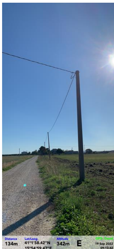
Figura 43 - Interferenza con linea telefonica - Vista in direzione Est - Punto di scatto 4142
