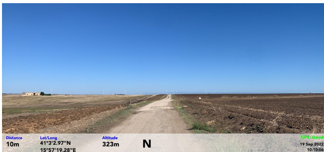
Figura 65 - Viabilità esistente da adeguare - Punto di scatto 4167
