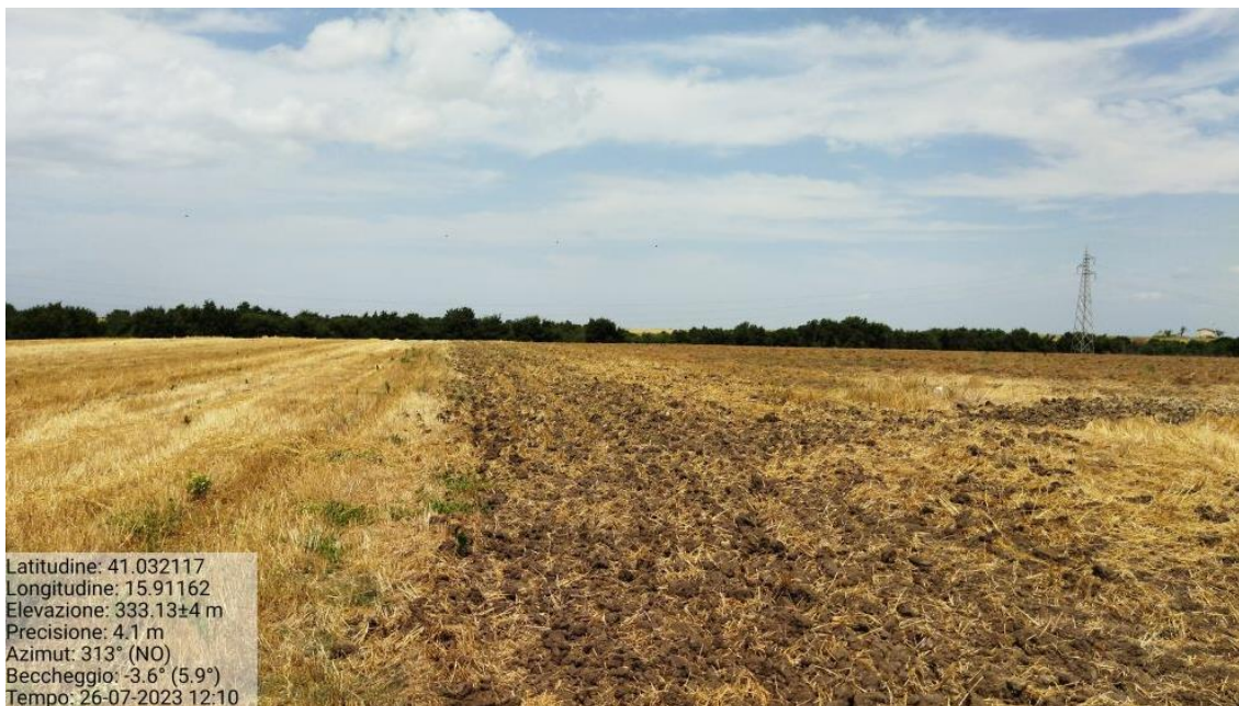
Figura 34 - Vista in direzione Nord-Ovest in corrispondenza della torre WTG 02 - Punto di scatto 06
