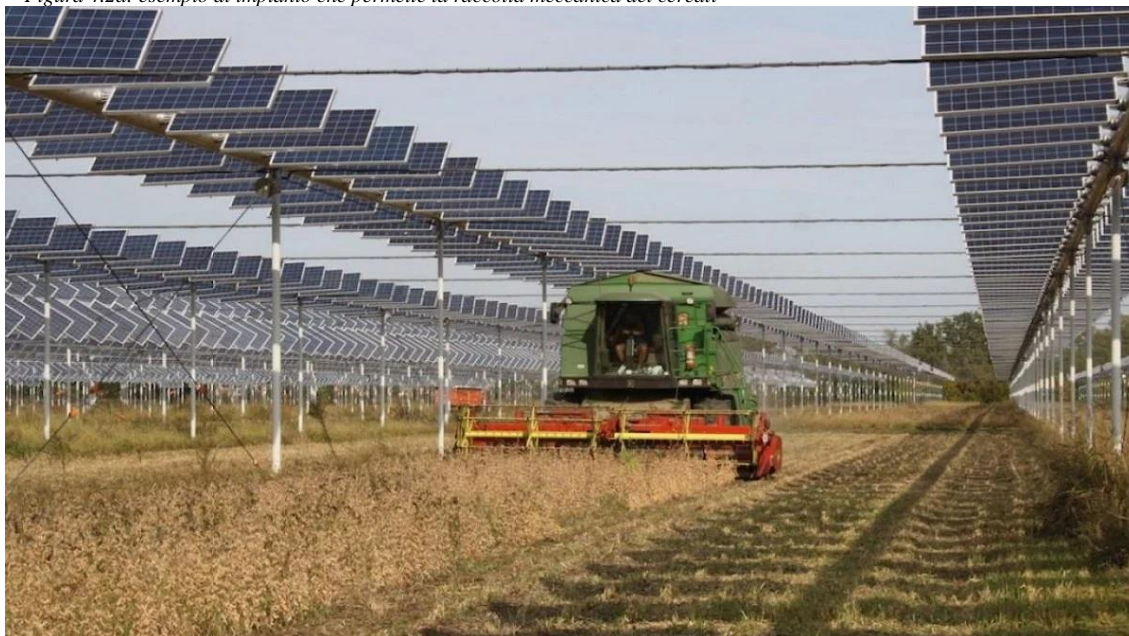
Figura 4.2a: esempio di impianto che permette la raccolta meccanica dei cereali
