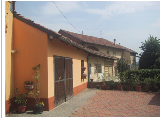
Fig. 5.2.C – Documentazione fotografica ricettori: AT144 da strada San Carlo
