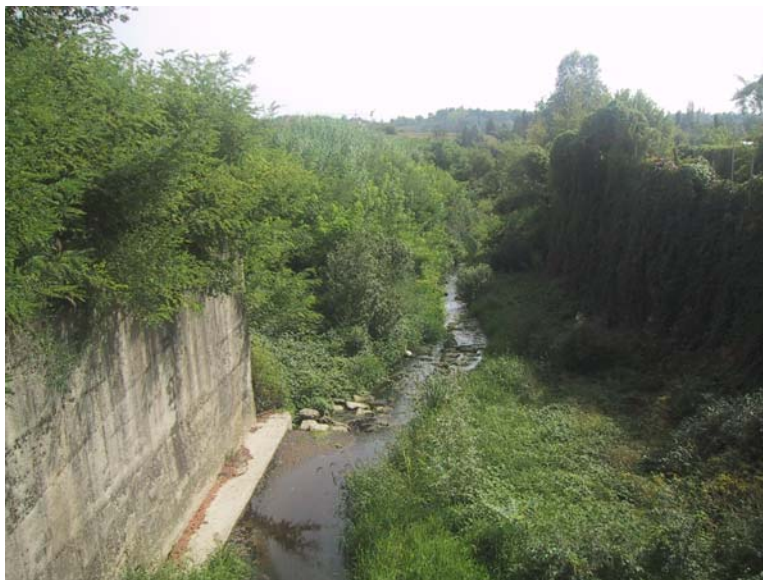
Fig. 3.1.C: Rio Rilate in corrispondenza dell'attraversamento della S.R. 10
