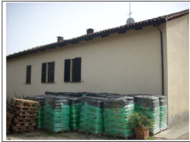
Fig. 5.2.G– Documentazione fotografica ricettori: AT342 da strada del Bobore
