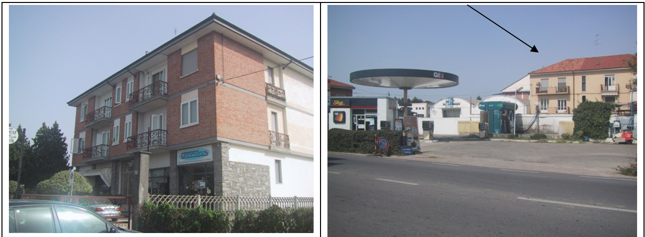
Fig. 5.2.K – Documentazione fotografica ricettori: AT524 (a sinistra) e AT548 visti da S.R. 10
