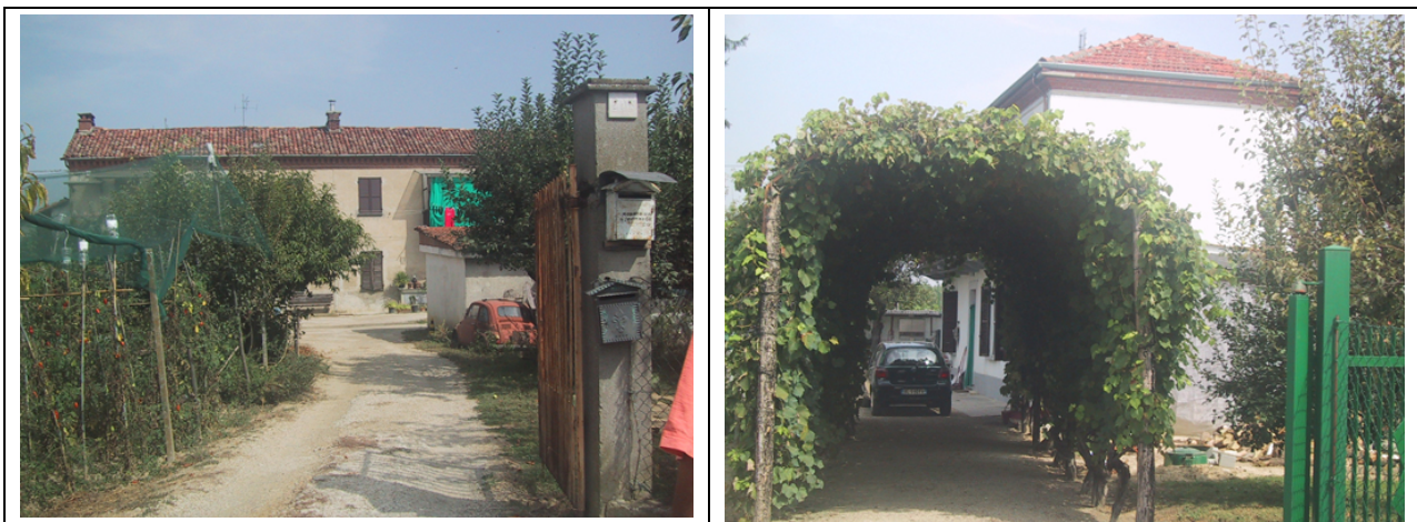
Fig. 5.2.B – Documentazione fotografica ricettori: AT108 (a sinistra) e AT111 visti da corso Alba (interno)
