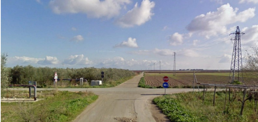
Regio Tratturello Salpitello di Tonti Trinitapoli nel punto di attraversamento da parte del cavidotto esterno
