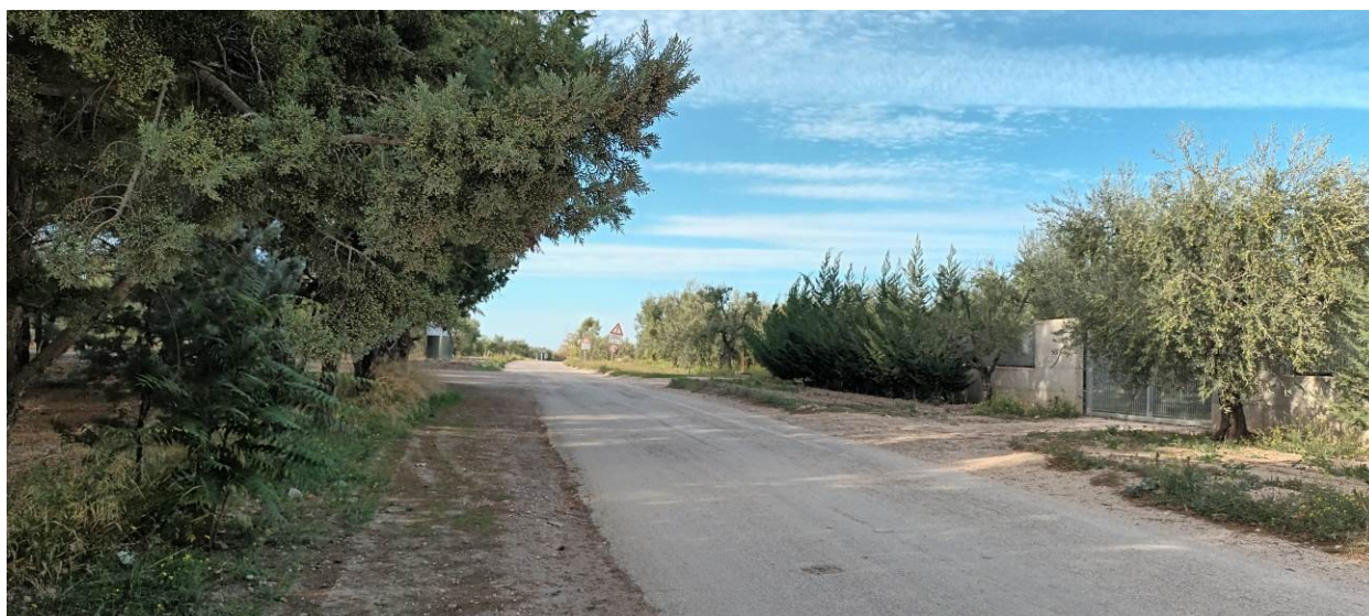
Foto P4.1: Vista lungo la SP 65, verso nord, interessata dal passaggio del cavidotto esterno
