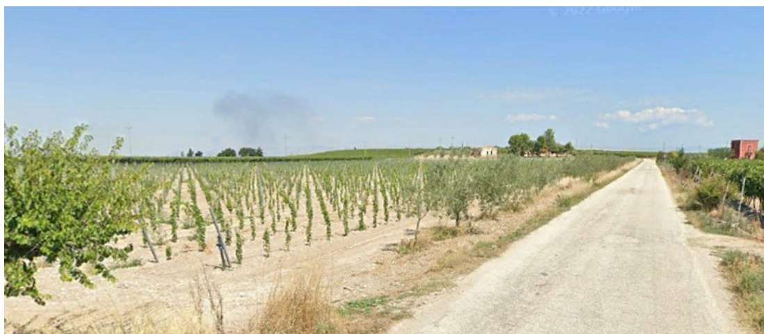
Foto P11_1: Vista lungo la SP65 verso nord, interessata dal passaggio del cavidotto esterno interrato
