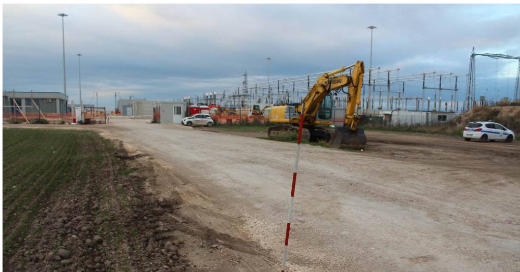
Foto P16: Vista della Stazione Terna in costruzione
