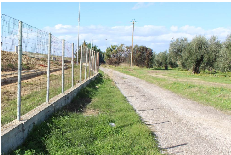
Foto P9_1: Vista lungo il perimetro della sede dell'Igiene Ambientale Consorzio Bacino Fg4 Srl, la viabilità secondaria esistente è interessata dal passaggio del cavidotto interno interrato in direzione della turbina C5, verso nord-ovest
