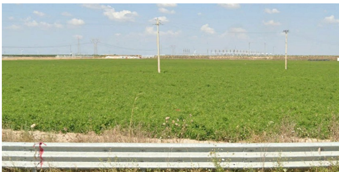
Foto P14_2: Vista della Stazione Terna in costruzione dalla SP 77
