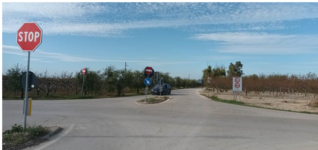
Foto P3.1: Vista all'incrocio tra la SP 62 e la SP 65 in direzione nord
