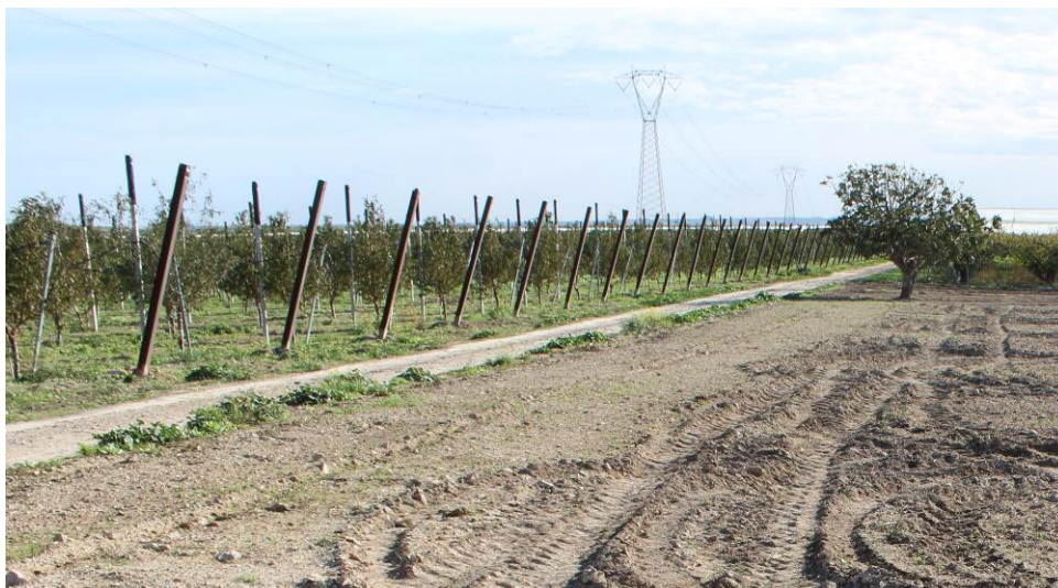
Foto P10: Vista lungo la viabilità secondaria esistente interessata dal passaggio del cavidotto interno interrato in direzione della turbina C7
