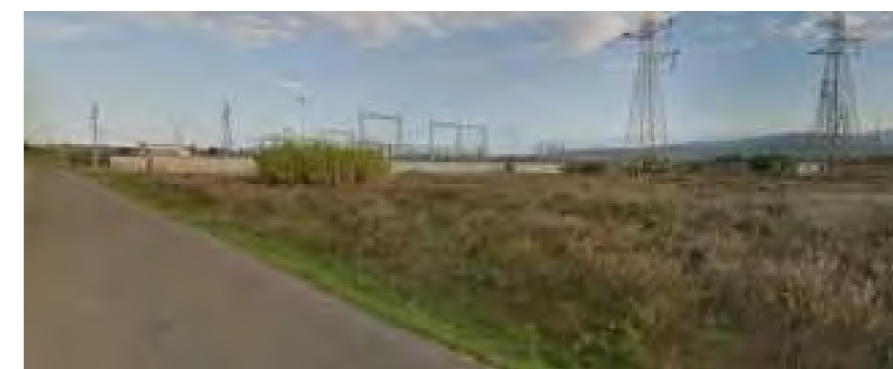
La Stazione Elettrica Terna
