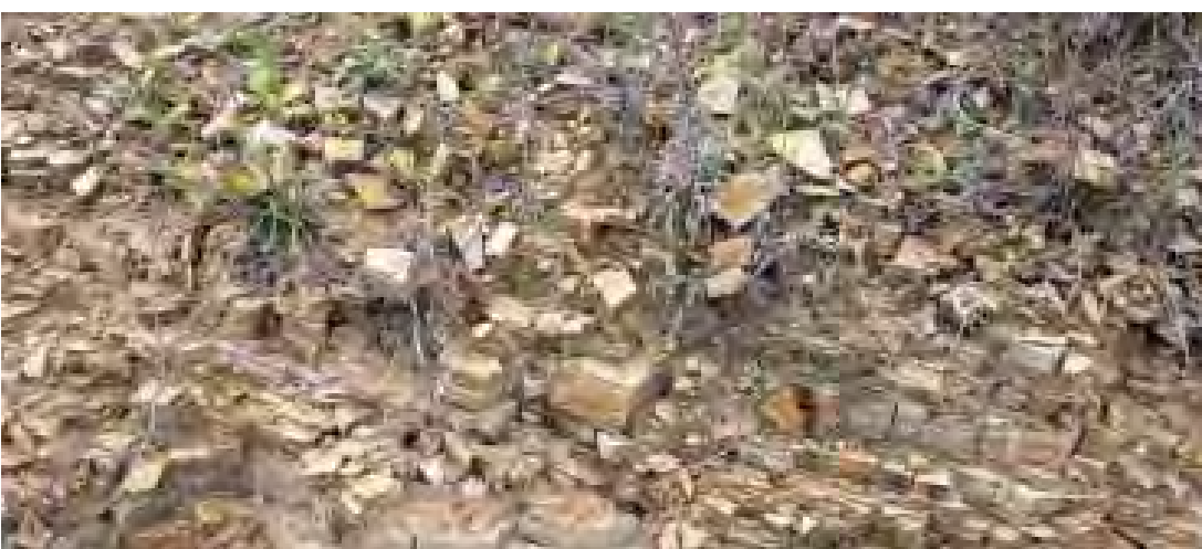
Caratteristica conformazione a blocchetti di pietra lungo i costoni laterali alla strada che conduce alla WTG 12
