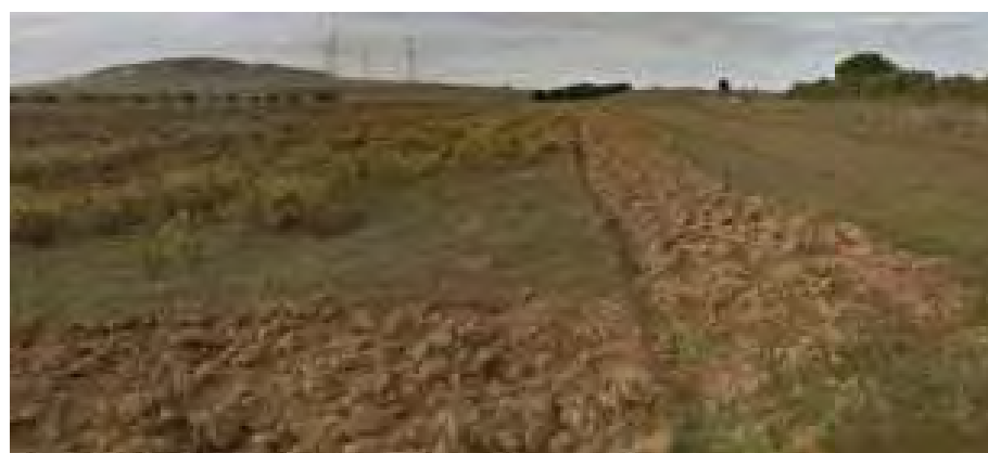
Il campo della Sottostazione
