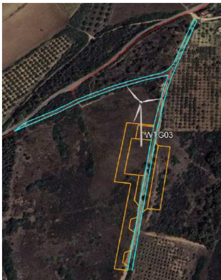
Figura 4 - Sito di installazione WTG 03
