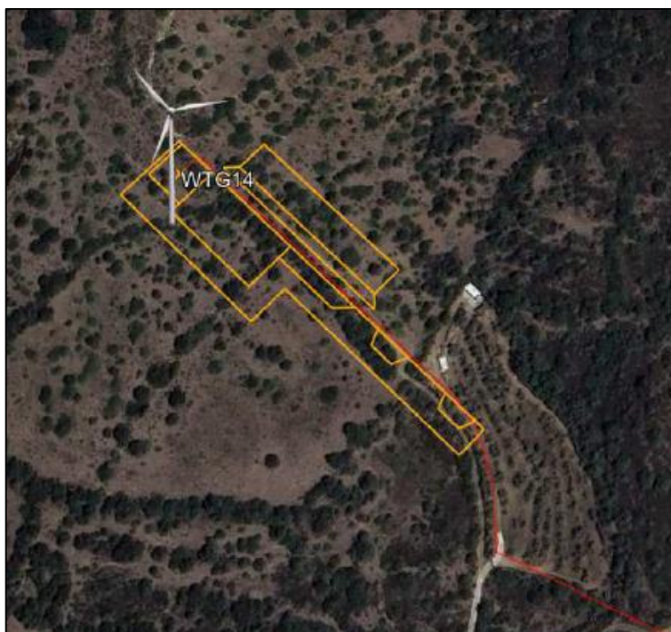
Figura 15 - Sito di installazione WTG 14
