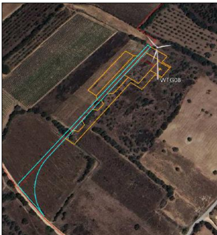
Figura 9 - Sito di installazione WTG 08
