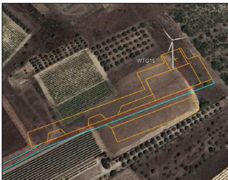
Figura 16 - Sito di installazione WTG 15
