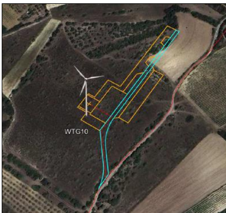
Figura 11 - Sito di installazione WTG 10
