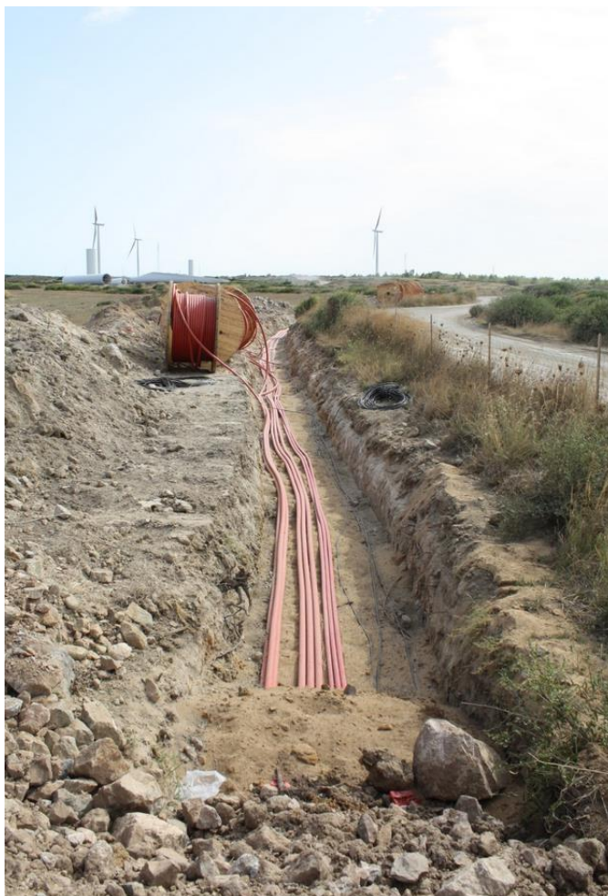
Figura 3.4 - Tipico scavo e linee interrate
