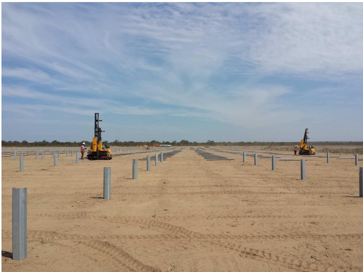
Figura 5.6 – Fase di infissione dei pali con profilo omega
