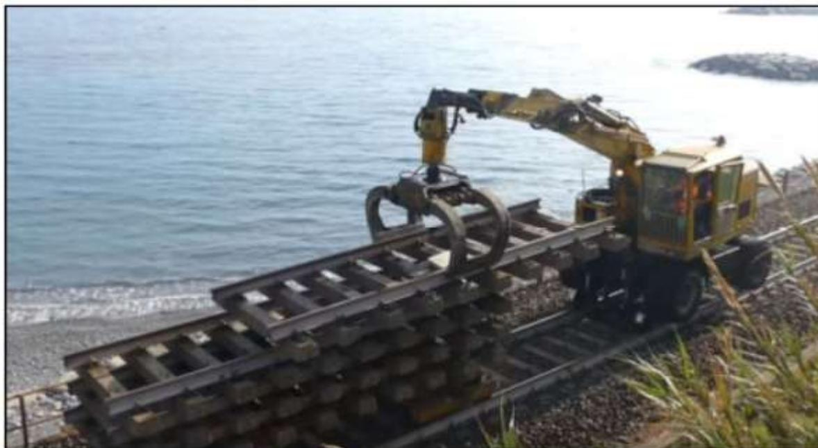
**Figura 10 - Posizionamento binario e traverse su carrello trasportatore**
