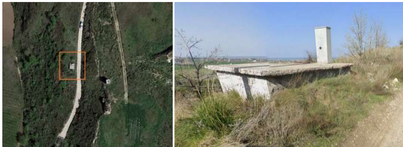
Figura 2-2 - Localizzazione manufatto da satellite e foto del manufatto interferente
