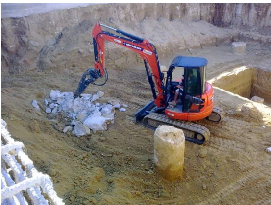
Demolizione con martellone
