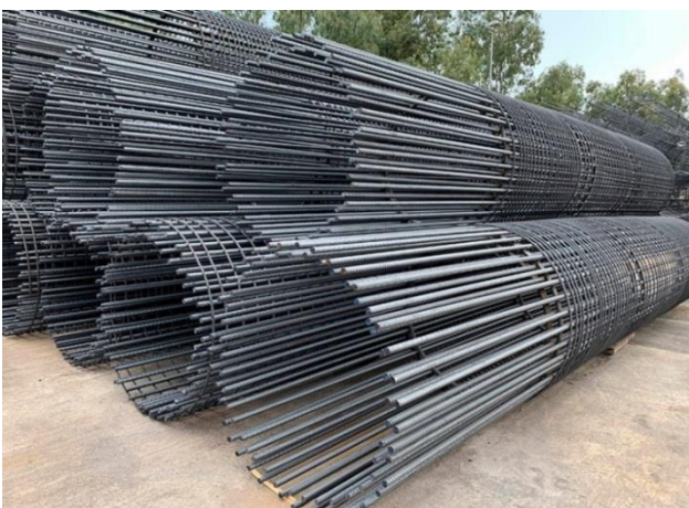
Gabbie di armatura pali
