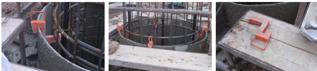
Staffe di sostegno ricavate tramite ossitaglio da lamiera piane di acciaio
