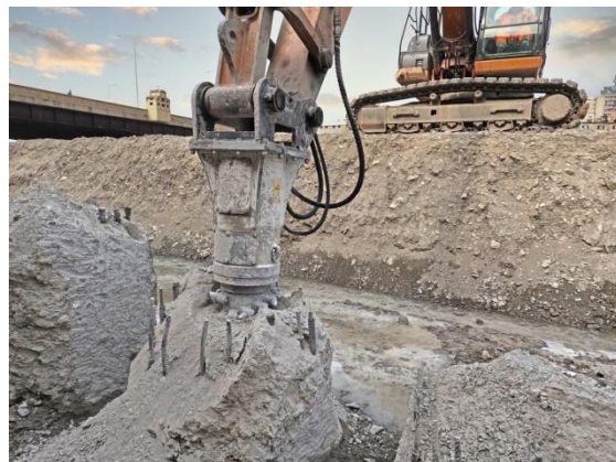
Demolizione con fresa
