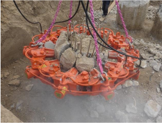
Demolizione con corona idraulica
