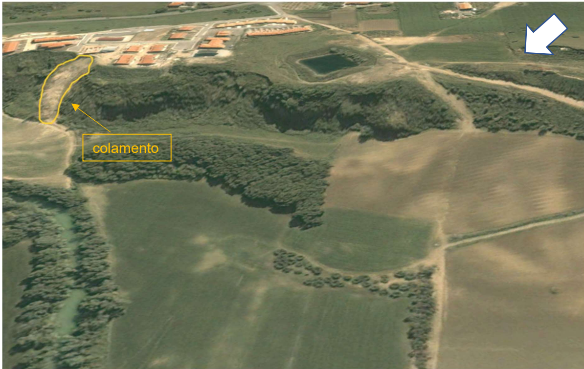
Figura 9.4 - Ortofoto (da google earth) del 2001, nella quale, si osserva un colamento.
