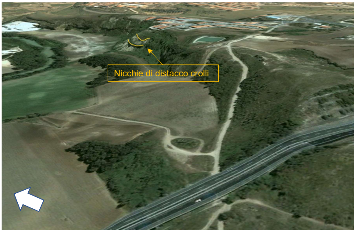
Figura 9.5 - Ortofoto (da google earth) del 2005, nella quale, vengono indicate le nicchie di distacco da cui hanno origine i crolli.
