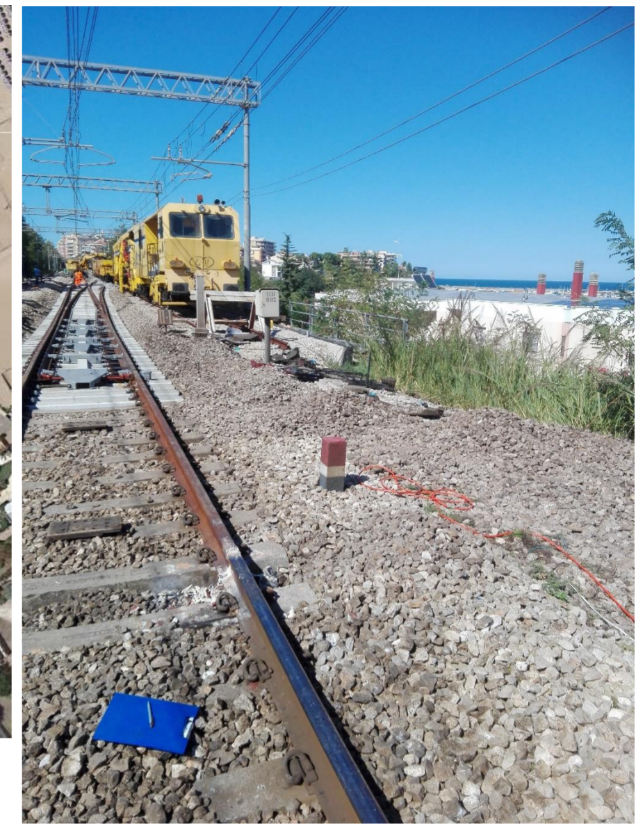
Fase di acquisizione ERT L2 Fine linea
