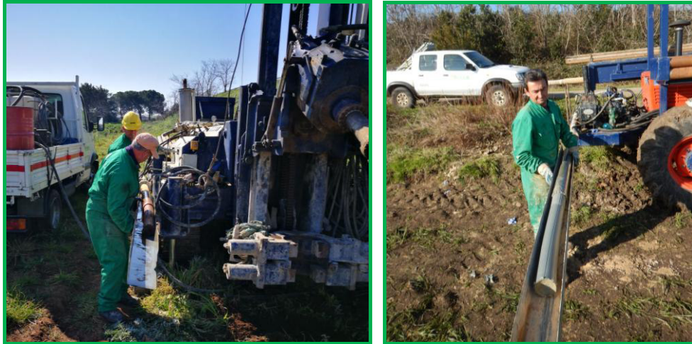
Foto 2.2 – Estrusione del carotaggio con estrusore a pistone
