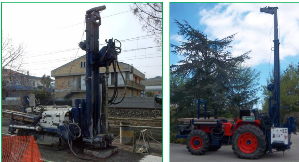
Foto 2.1 - Macchine perforatrici utilizzate.
