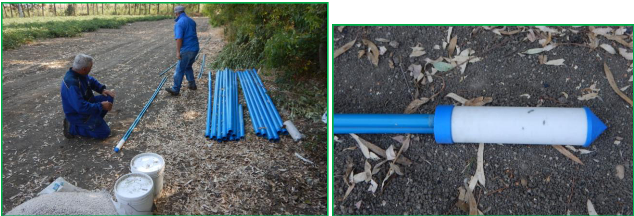
Foto 2.7 – Fase di preparazione del piezometro di Casagrande; a destra, particolare della cella Casagrande a doppio tubo utilizzata.
