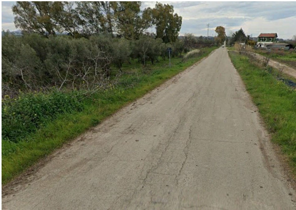
Figura 2: Rappresentazione stato di fatto (direzione Nord/Ovest)
