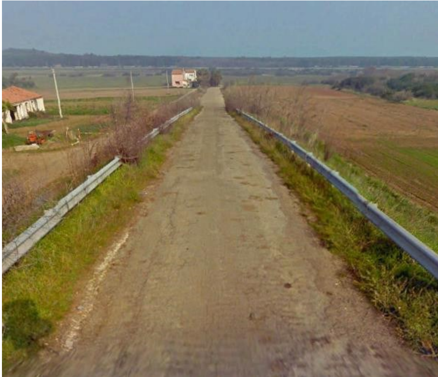
Figura 2: Rappresentazione stato di fatto (Direzione Nord)
