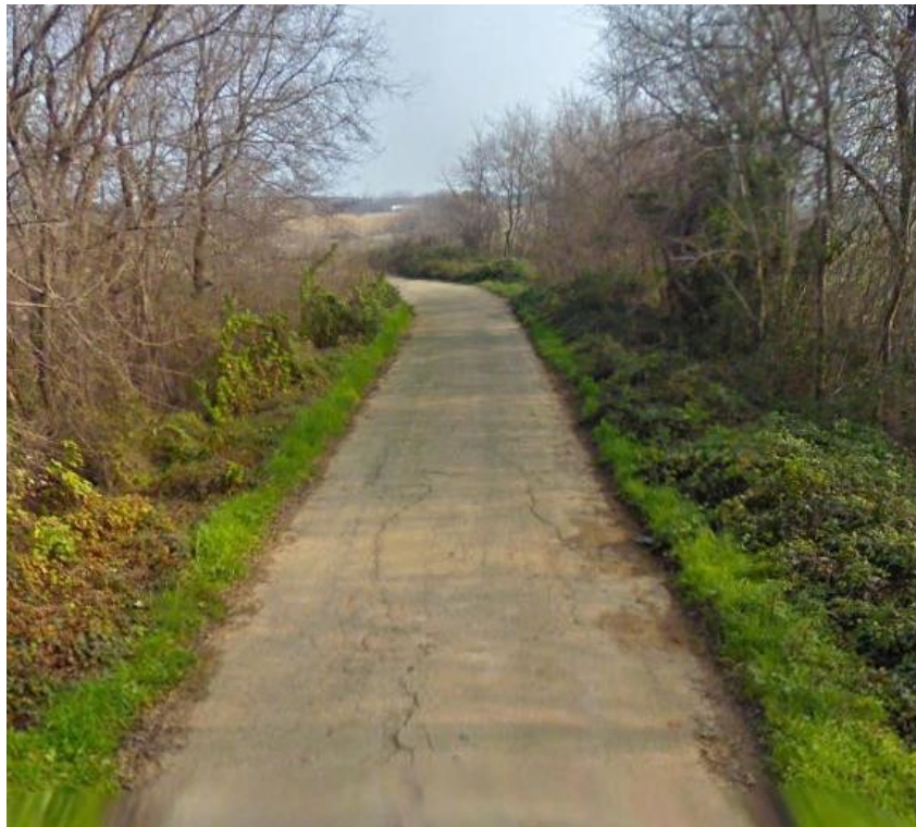
Figura 3: Rappresentazione stato di fatto (Direzione Nord)
