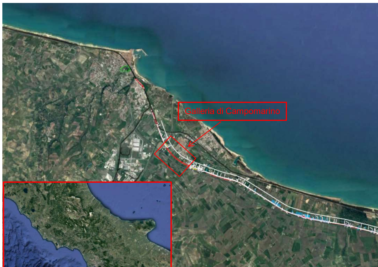
Figura 2.1 - Corografia dell'area di studio con individuazione del tratto in cui verrà realizzata la galleria di Campomarino.
