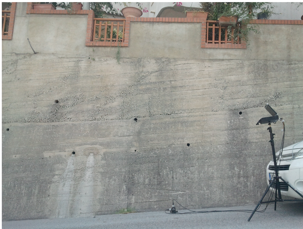
Foto 2: Postazione Vibr_09 loc.fà Contrada Marcina superiore Grotteria (RC)
