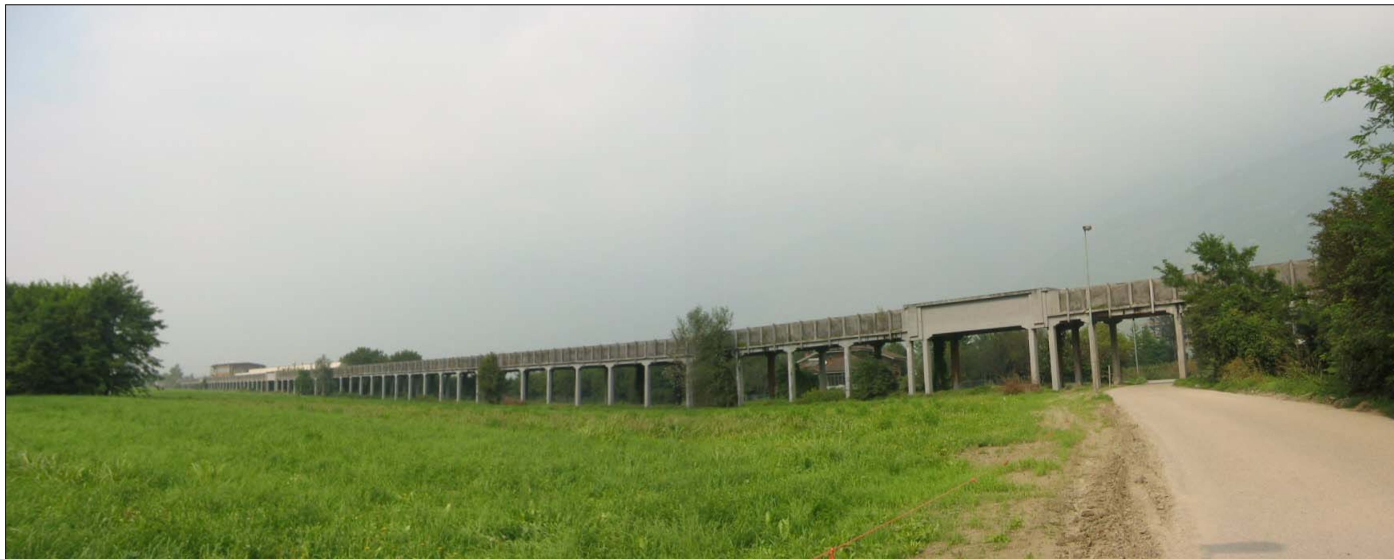
Canale di alimentazione di una centrale elettrica nella piana di Bruzolo
