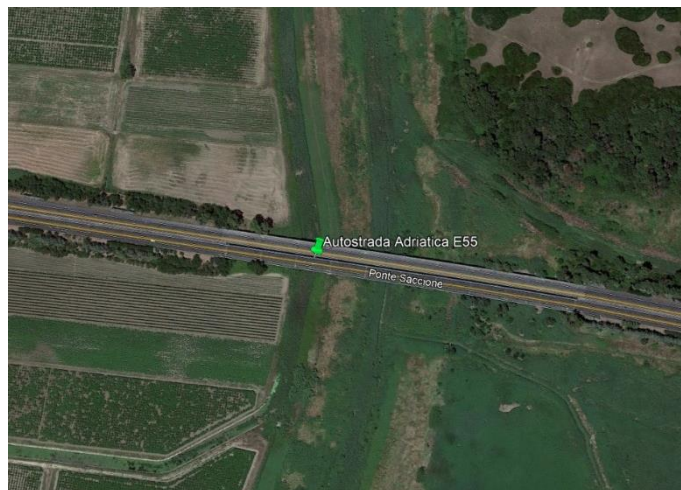
Figura 7-3. Ponte Saccione dell'A14.
