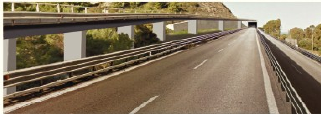
STATO POST OPERAM
