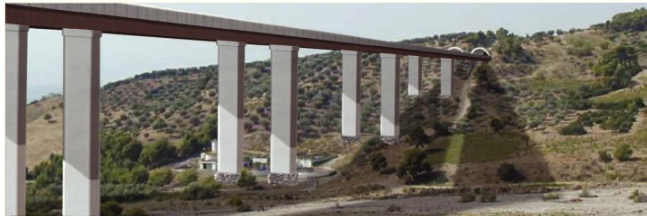
STATO POST OPERAM
