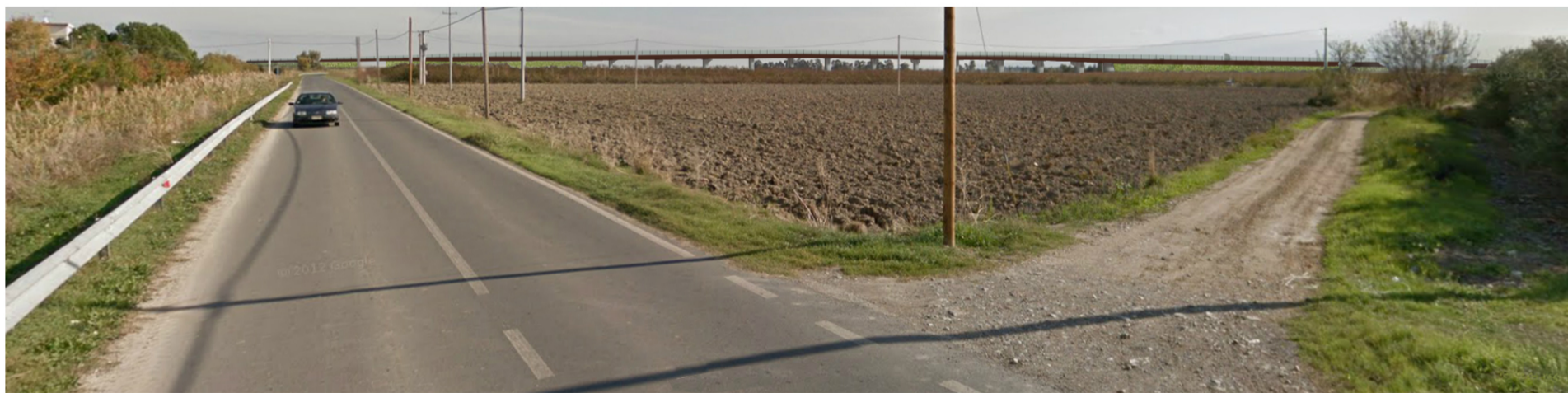
Il viadotto percepito dalla strada - VISUALE APERTA
