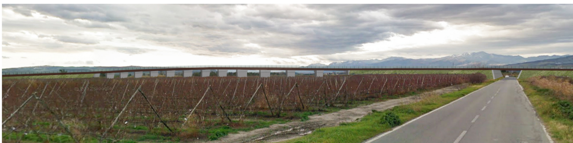
Il viadotto percepito dalla strada - VISUALE APERTA
