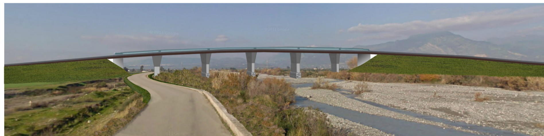
Il viadotto percepito dalla strada - VISUALE APERTA
