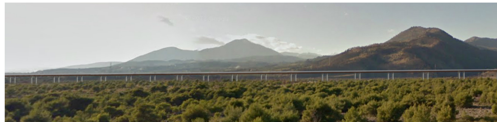
Il viadotto percepito dalla strada - VISUALE APERTA
