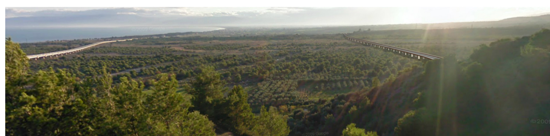
Il viadotto percepito dalla strada - VISUALE APERTA
