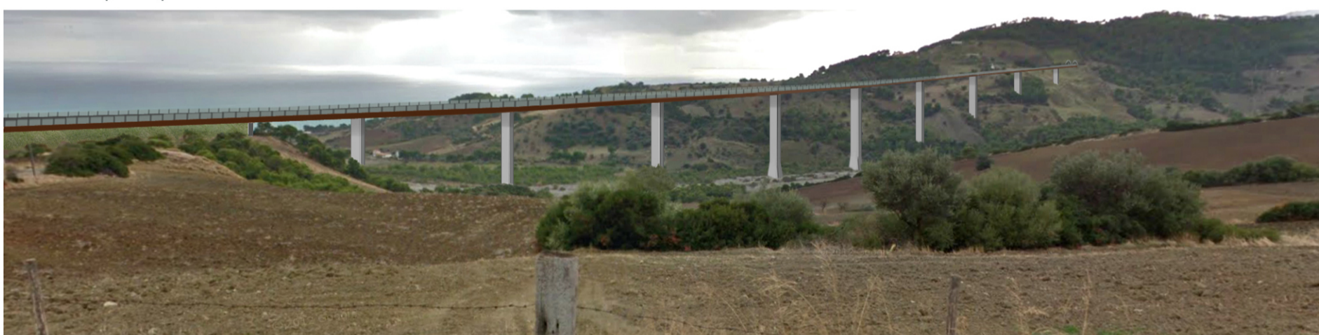
Il viadotto percepito dalla strada - VISUALE APERTA
