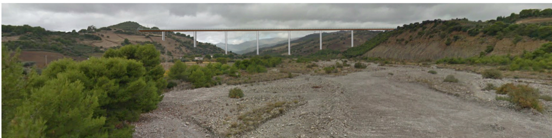
Il viadotto percepito dalla strada - VISUALE APERTA
