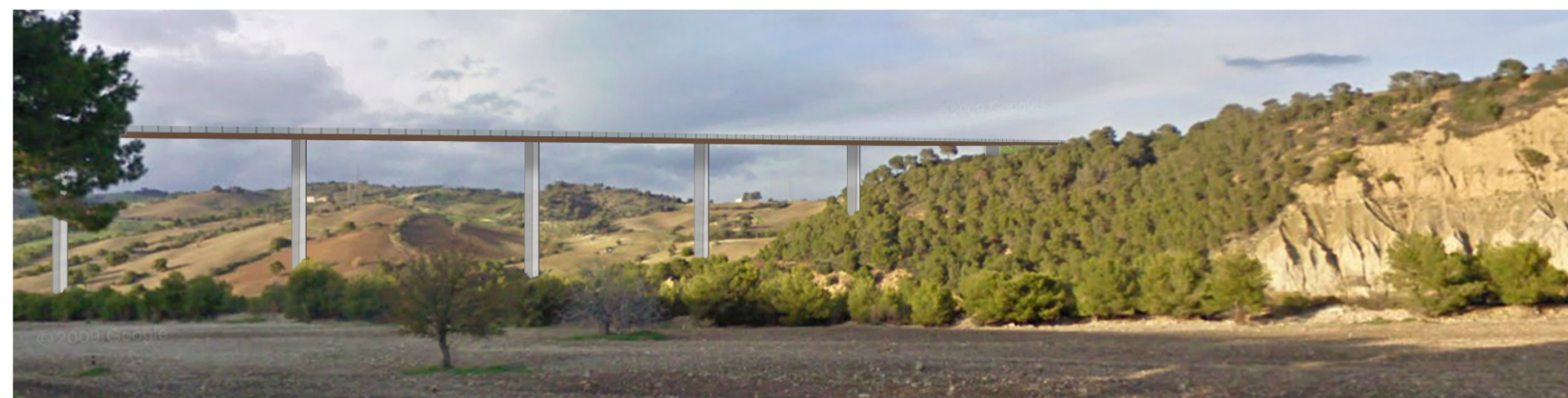
Il viadotto percepito dalla strada - VISUALE APERTA
