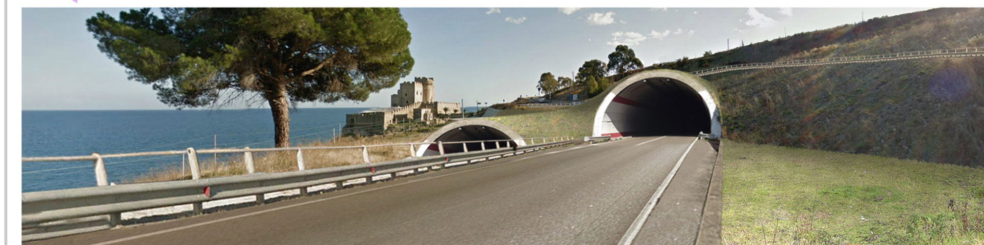
A Tratto della SS 106 Jonica - POST OPERAM
