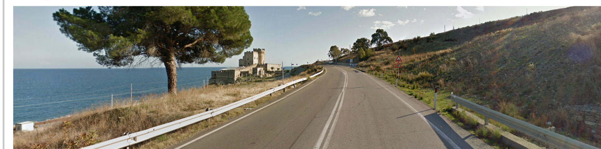
A Tratto della SS 106 Jonica - ANTE OPERAM
