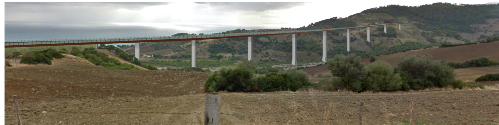
Il viadotto percepito dalla strada - VISUALE APERTA
