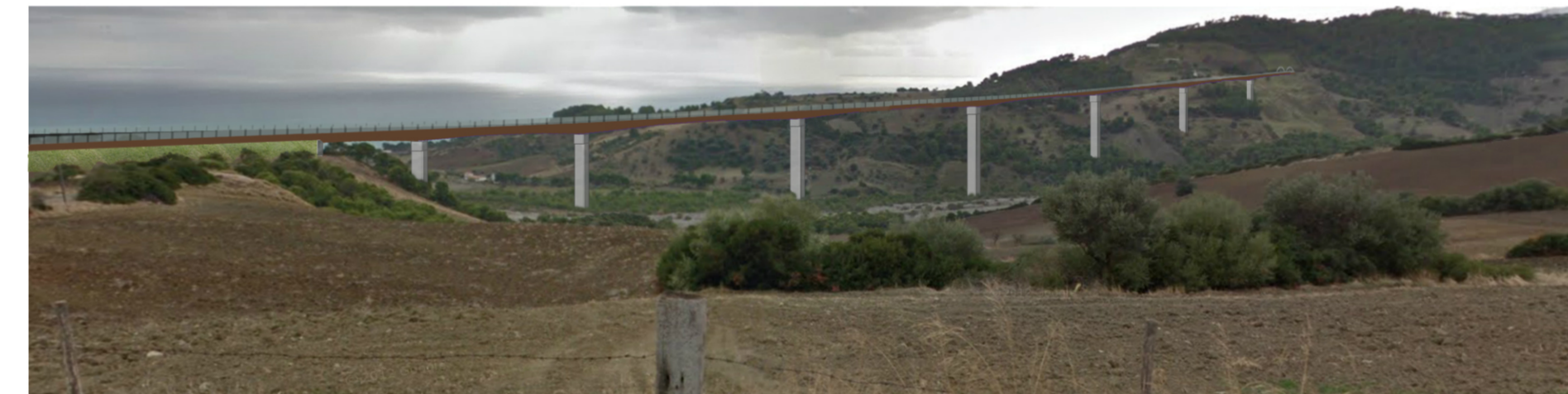
Il viadotto percepito dalla strada - VISUALE APERTA
