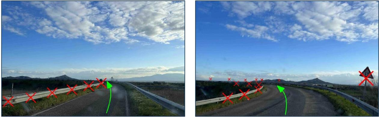
**Figura 5-12: Uscita dalla SS131 – rimozione temporanea dei guardrail (Intervento 6)**
