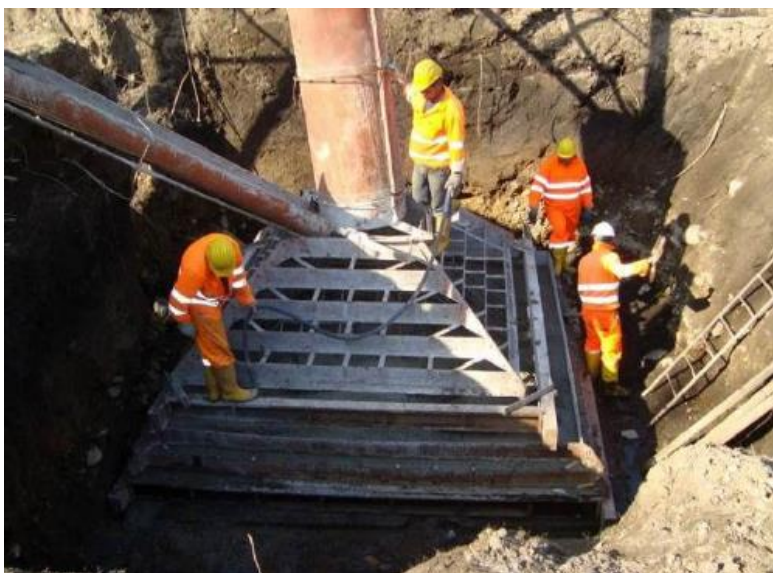
Figura 6-20 – Realizzazione piedino del traliccio
