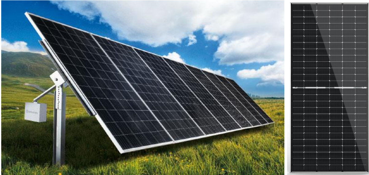
Figura 6-7 - Esempio di pannelli fotovoltaici a terra inseguitori solari di color nero
