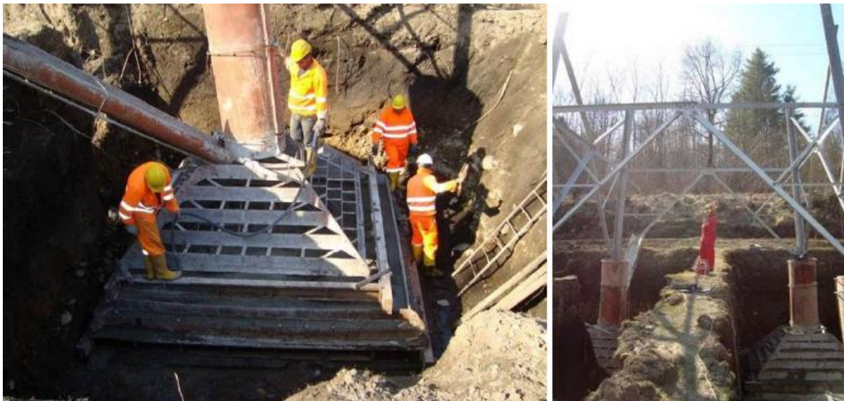
Figura 6-15 – Realizzazione piedino del traliccio
