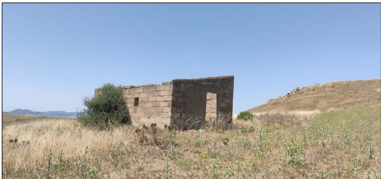
Figura 13: foto del manufatto rurale n.2
