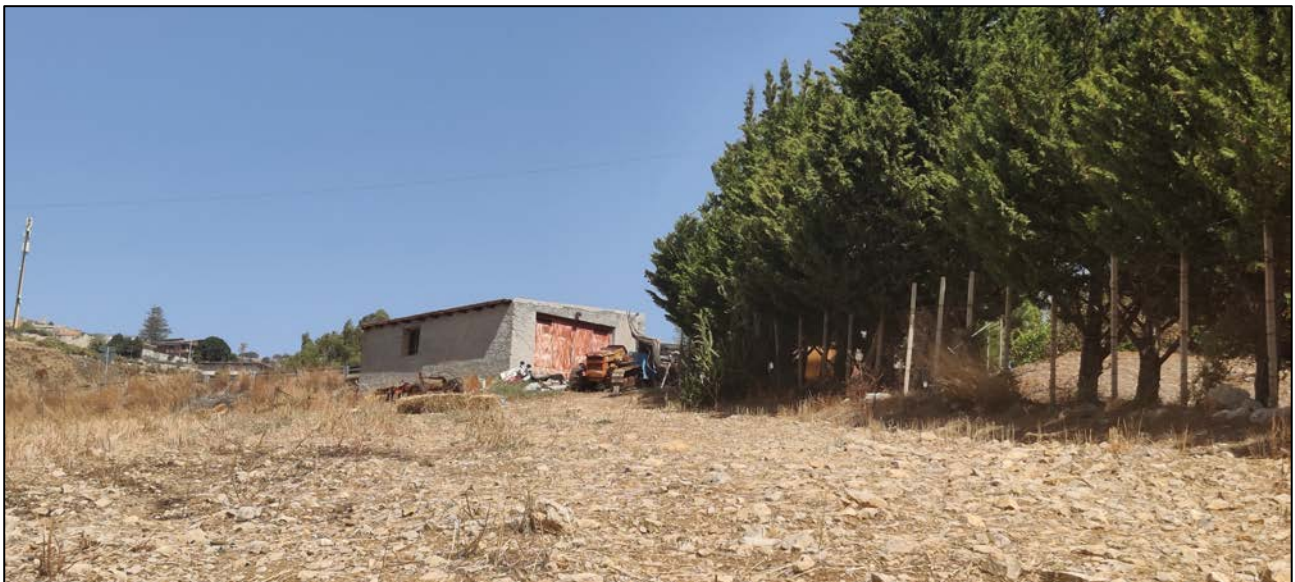
Figura 33: foto manufatto rurale n.12
