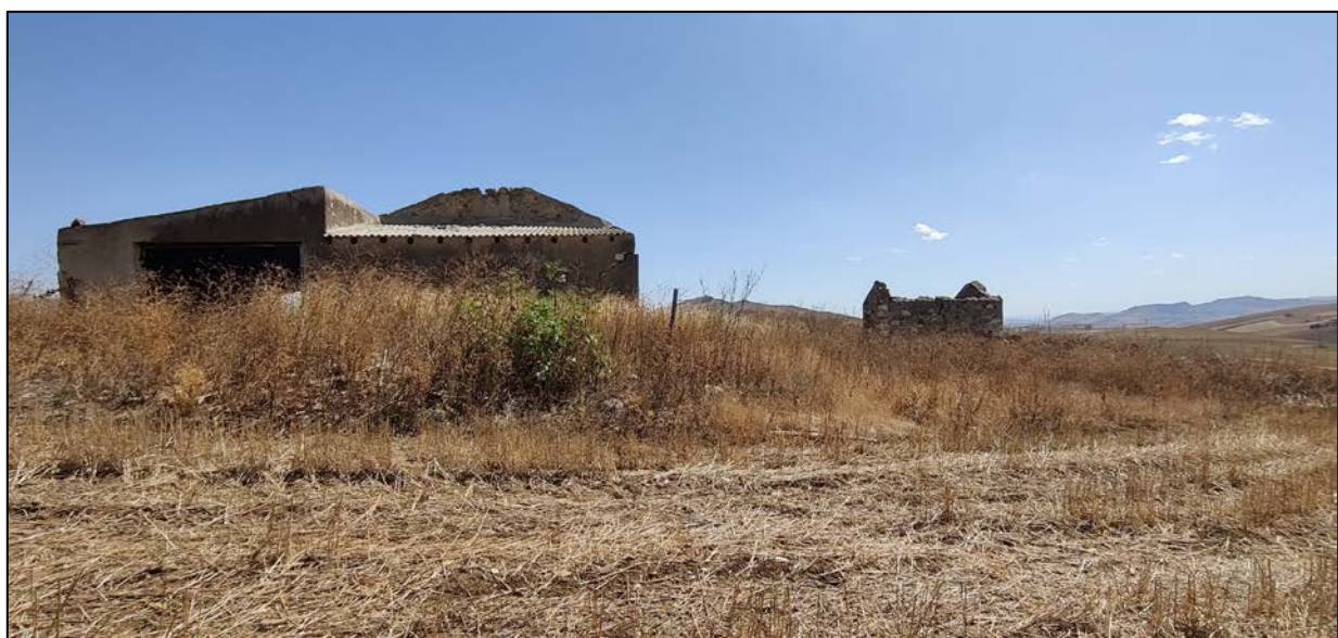
Figura 17: foto del manufatto rurale n.4
