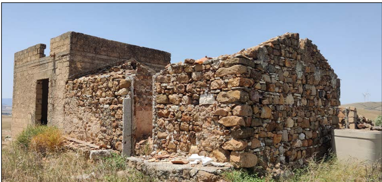
Figura 11: foto del manufatto rurale n.1
