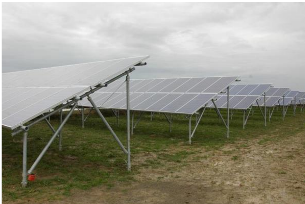
Figura 22: Esempio impianto a strutture fisse
