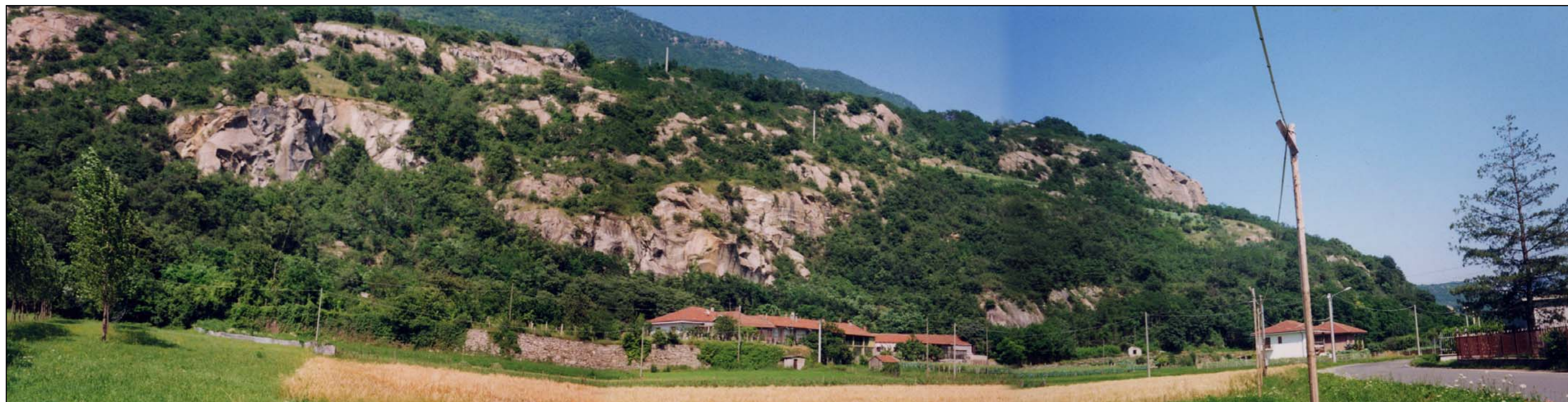
Il versante all'imbocco della galleria Gravio verso Torino
