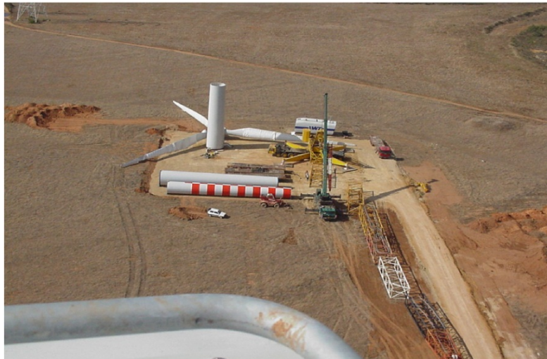
Figura 3 – Piazzola per il montaggio dell'aerogeneratore
