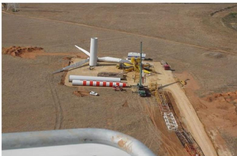
Figura 23 – Piazzola per il montaggio dell'aerogeneratore
