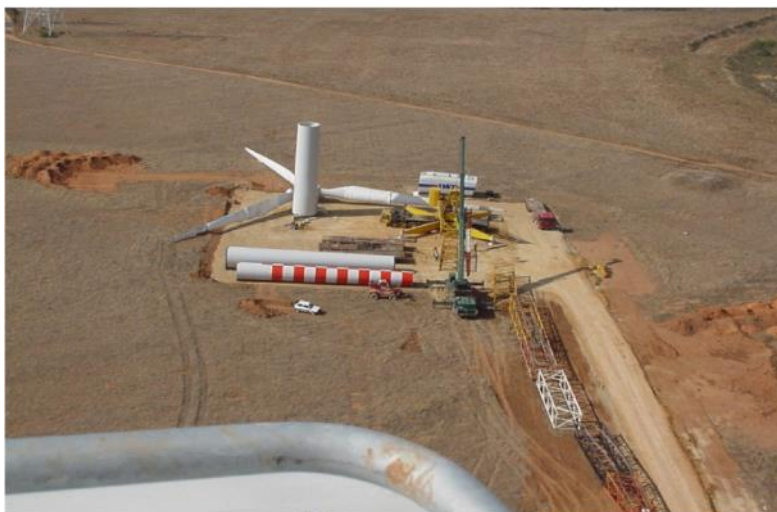
Figura 2 – Piazzola per il montaggio dell'aerogeneratore
