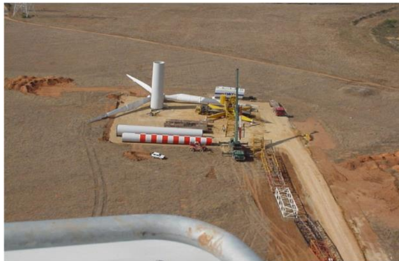
Figura 9 – Piazzola per il montaggio dell'aerogeneratore
