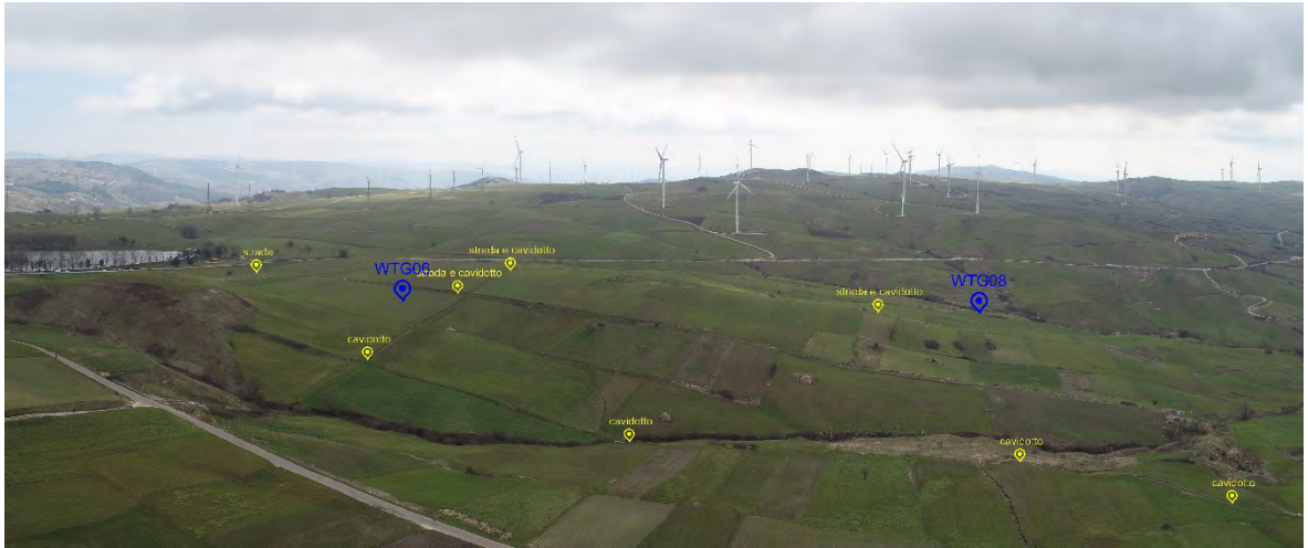
Immagine da drone con indicazione della futura torre WTG 06-WTG 08 e del percorso del cavidotto
