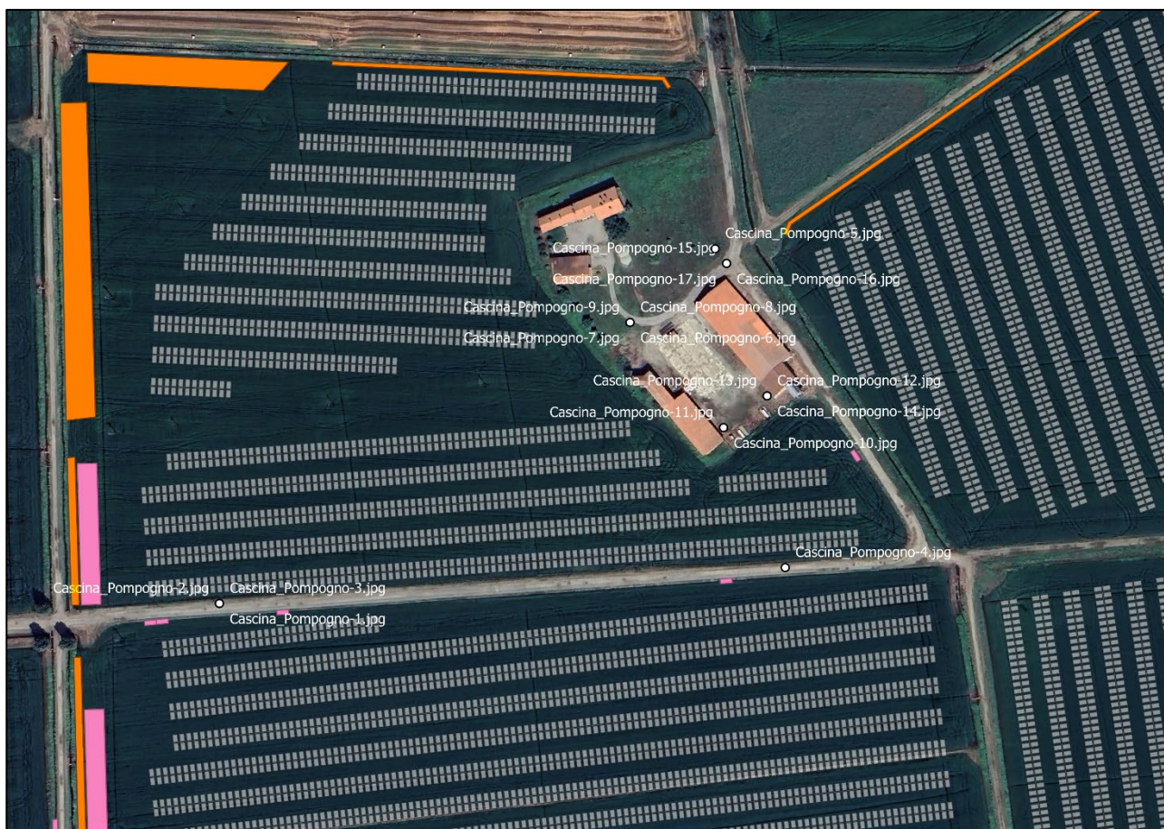
Punti di vista Cascina Pompogno
