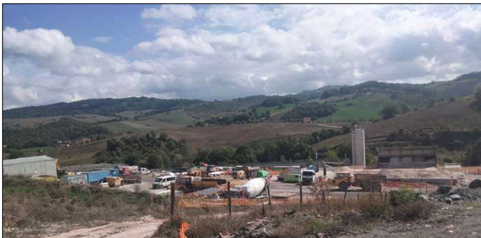
Cantiere Base località Piano dell'Abate VIII C.O. settembre 2023
