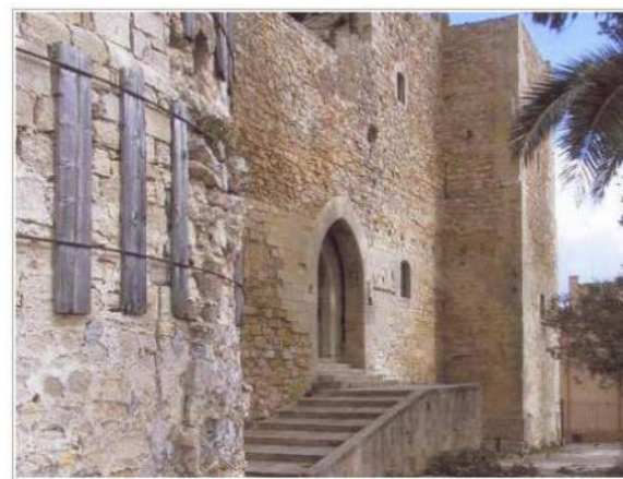
Ingresso al castello
