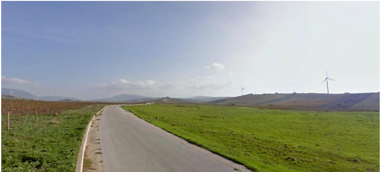
Figura 80 R10 - BENI ISOLATI – BAGLIO4_ ANTE
