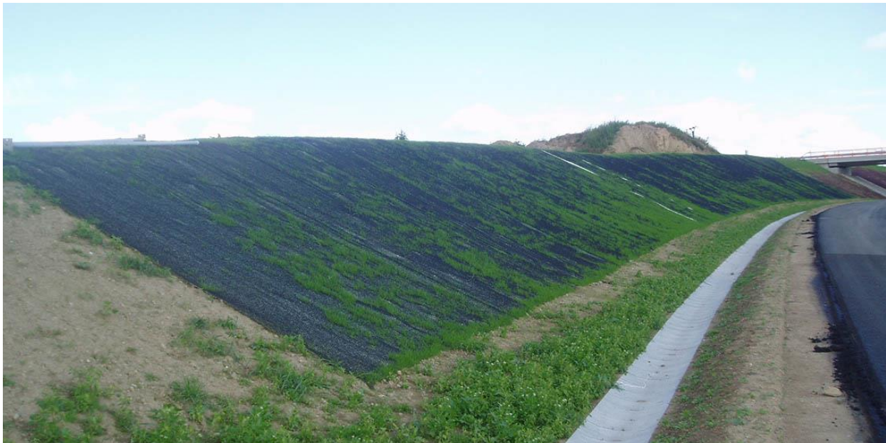
Figura 28 - Esempi di applicazioni di geostuoie
