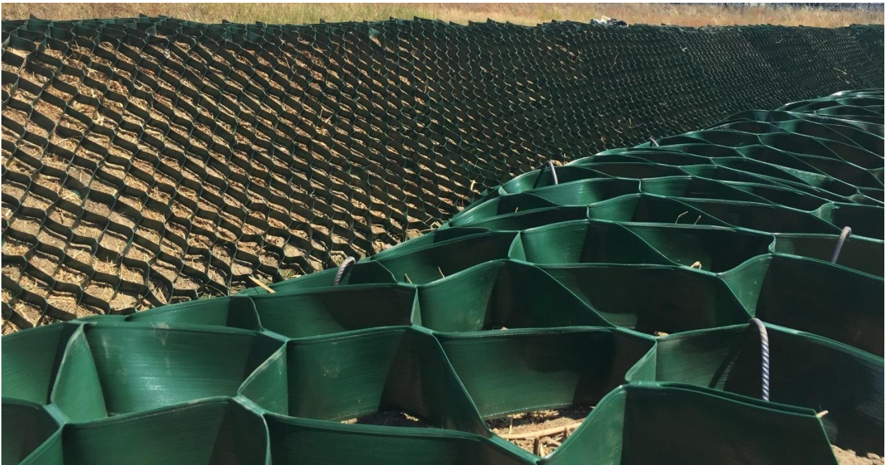
Figura 30 - Esempio di applicazioni con geocelle
