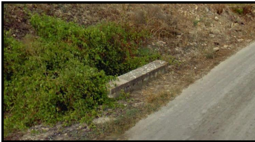
Figura 11 - foto dell'impluvio costituente l'interferenza "Int.11"
