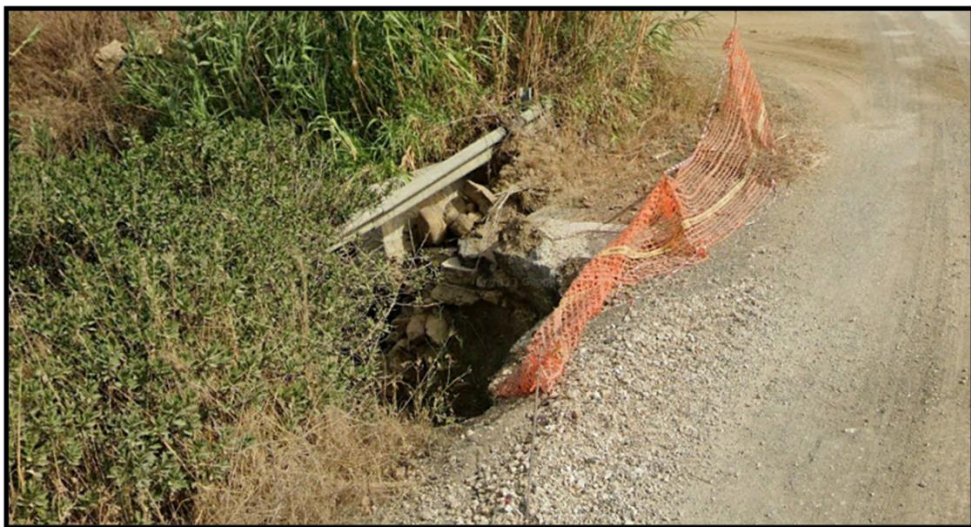
Figura 40 - foto dell'impluvio costituente l'interferenza "Int.40"
