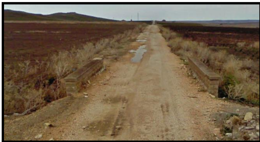
Figura 50 - foto dell'impluvio costituente l'interferenza "Int.50"
