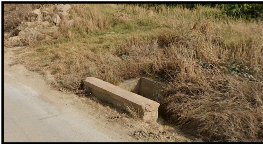
Figura 33 - foto dell'impluvio costituente l'interferenza "Int.33"
