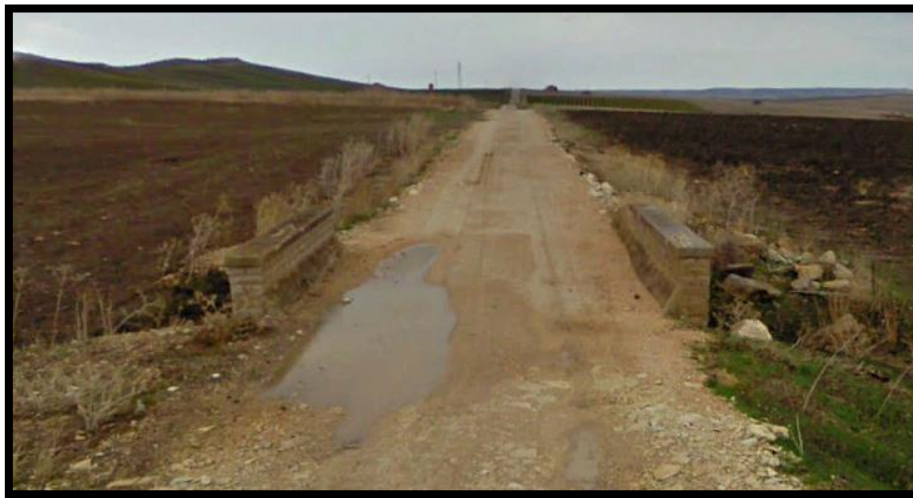
Figura 51 - foto dell'impluvio costituente l'interferenza "Int.51"
