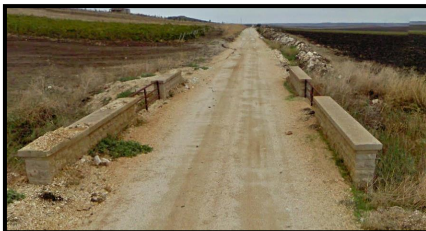
Figura 48 - foto dell'impluvio costituente l'interferenza "Int.48"
