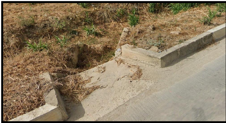
Figura 31 - foto dell'impluvio costituente l'interferenza "Int.31"
