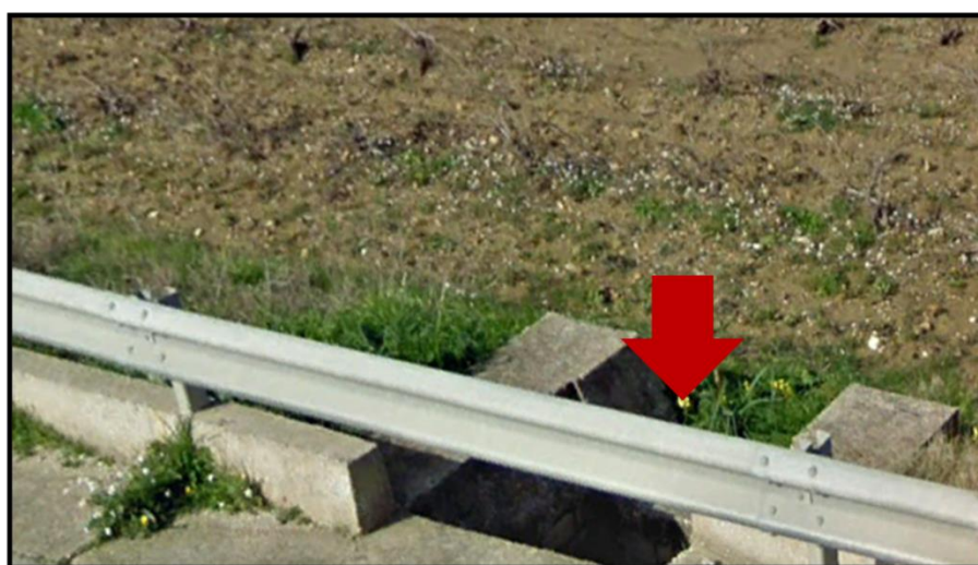
Figura 24 - foto dell'impluvio costituente l'interferenza "Int.24"
