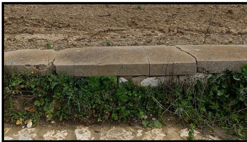
Figura 9 - foto dell'impluvio costituente l'interferenza "Int.9"
