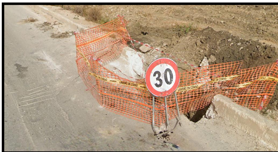
Figura 30 - foto dell'impluvio costituente l'interferenza "Int.30"
