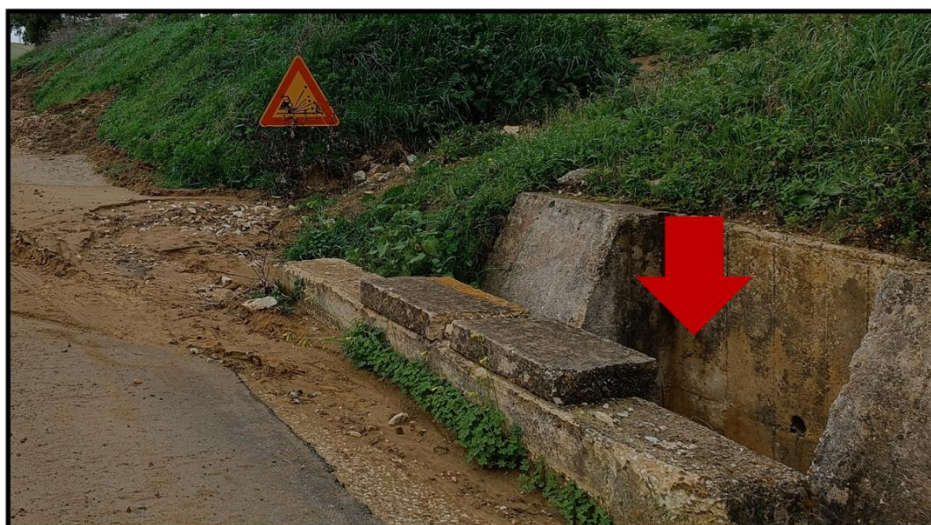
Figura 16 - foto dell'impluvio costituente l'interferenza "Int.16"
