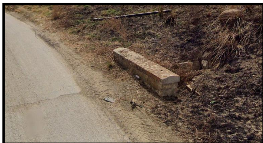
Figura 36 - foto dell'impluvio costituente l'interferenza "Int.36"
