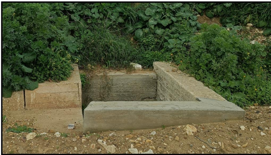
Figura 19 - foto dell'impluvio costituente l'interferenza "Int.19"
