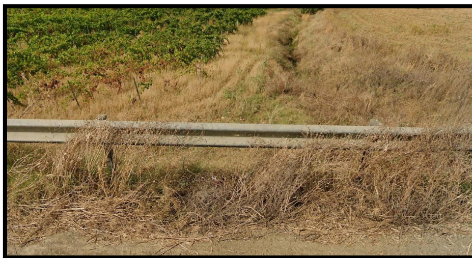
Figura 32 - foto dell'impluvio costituente l'interferenza "Int.32"
