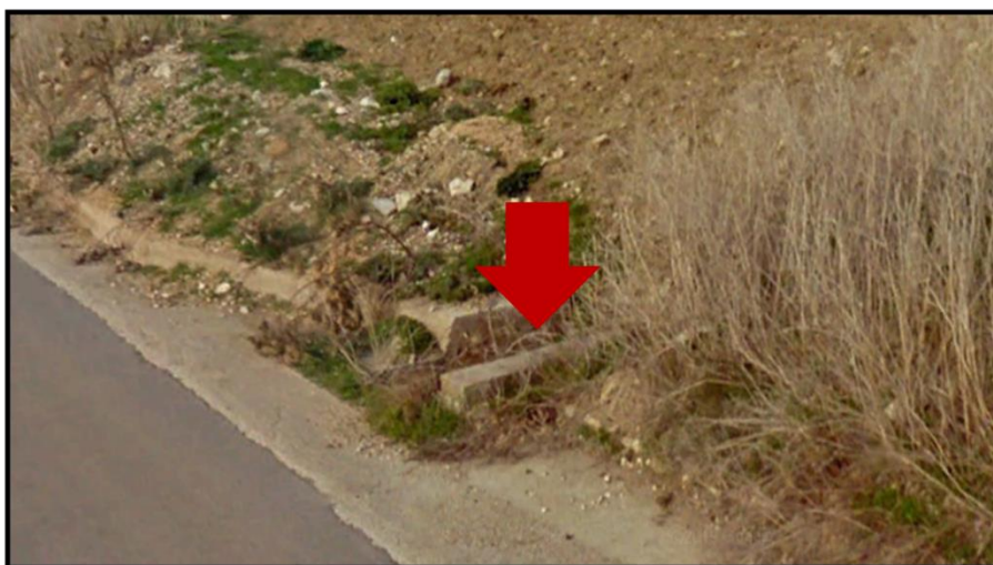
Figura 20 - foto dell'impluvio costituente l'interferenza "Int.20"
