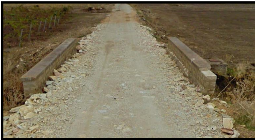
Figura 49 - foto dell'impluvio costituente l'interferenza "Int.49"
