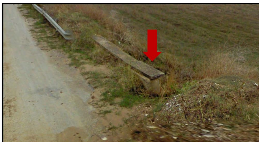
Figura 18 - foto dell'impluvio costituente l'interferenza "Int.18"
