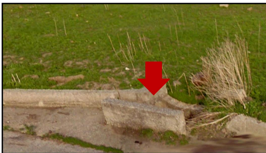
Figura 22 - foto dell'impluvio costituente l'interferenza "Int.22"
