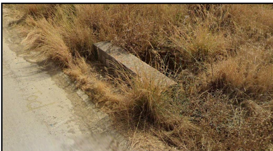
Figura 34 - foto dell'impluvio costituente l'interferenza "Int.34"
