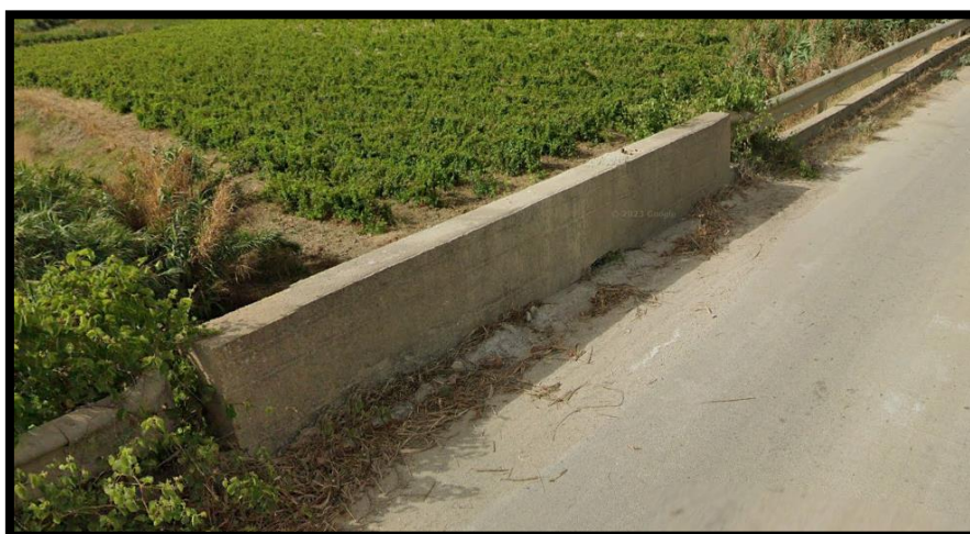
Figura 28 - foto dell'impluvio costituente l'interferenza "Int.28"
