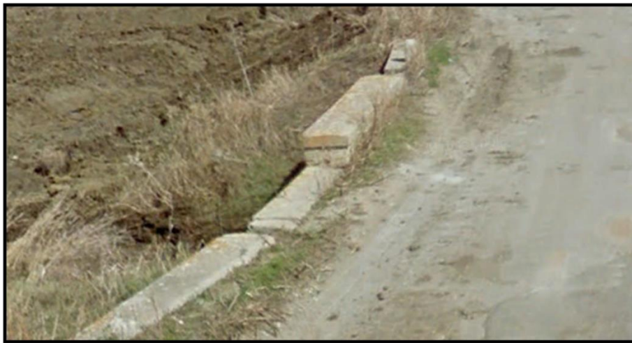
Figura 45 - foto dell'impluvio costituente l'interferenza "Int.45"
