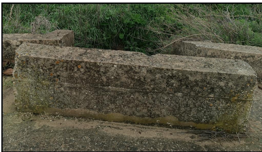
Figura 21 - foto dell'impluvio costituente l'interferenza "Int.21"
