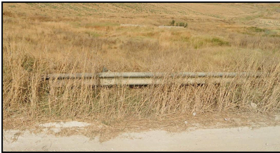
Figura 37 - foto dell'impluvio costituente l'interferenza "Int.37"
