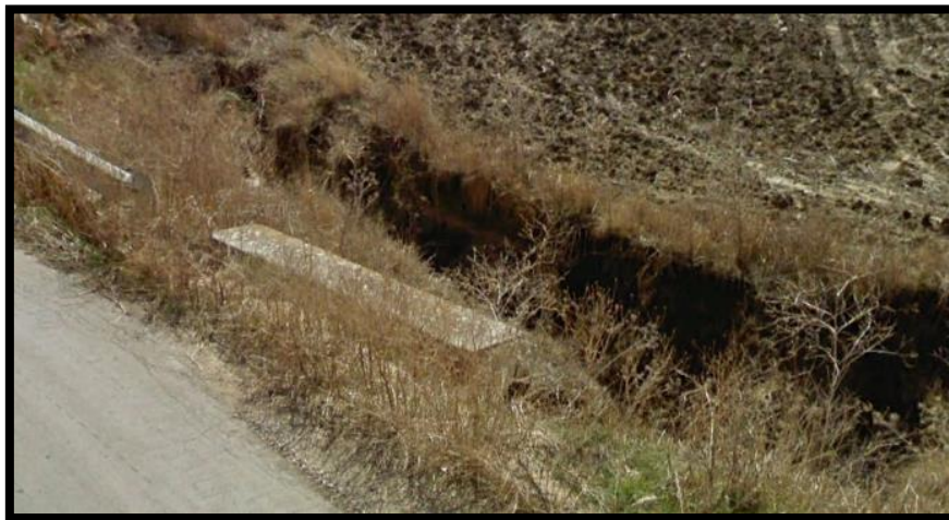
Figura 47 - foto dell'impluvio costituente l'interferenza "Int.47"
