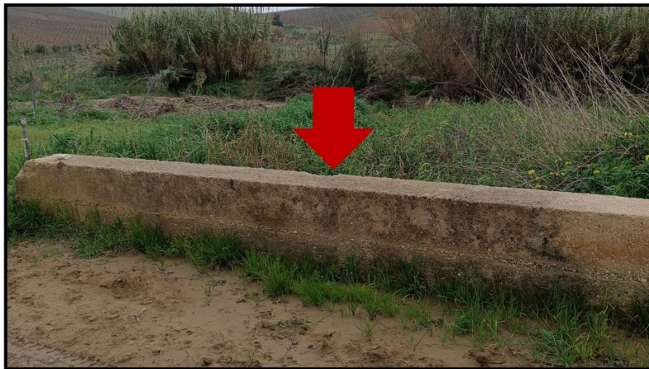
Figura 15 - foto dell'impluvio costituente l'interferenza "Int.15"
