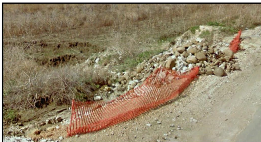
Figura 46 - foto dell'impluvio costituente l'interferenza "Int.46"
