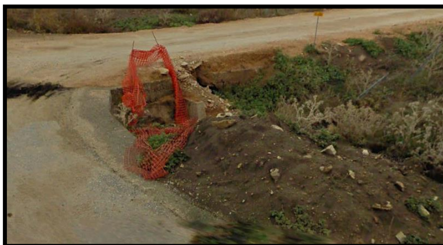
Figura 52 - foto dell'impluvio costituente l'interferenza "Int.52"
