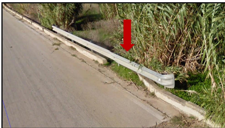
Figura 27 - foto dell'impluvio costituente l'interferenza "Int.27"
