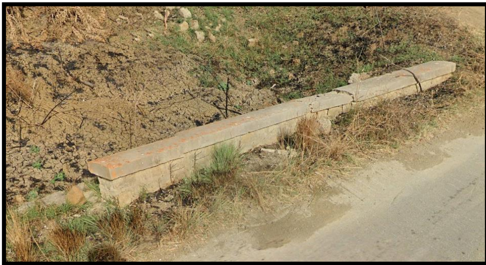
Figura 41 - foto dell'impluvio costituente l'interferenza "Int.41"
