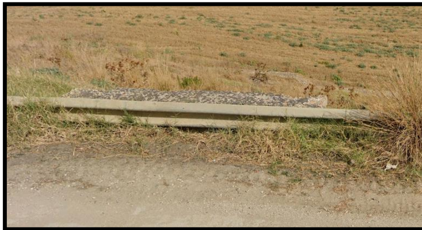
Figura 35 - foto dell'impluvio costituente l'interferenza "Int.35"
