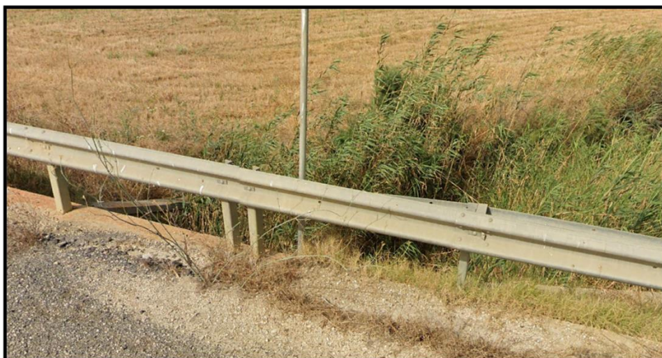
Figura 42 - foto dell'impluvio costituente l'interferenza "Int.42"
