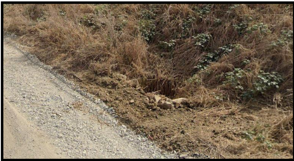
Figura 39 - foto dell'impluvio costituente l'interferenza "Int.39"
