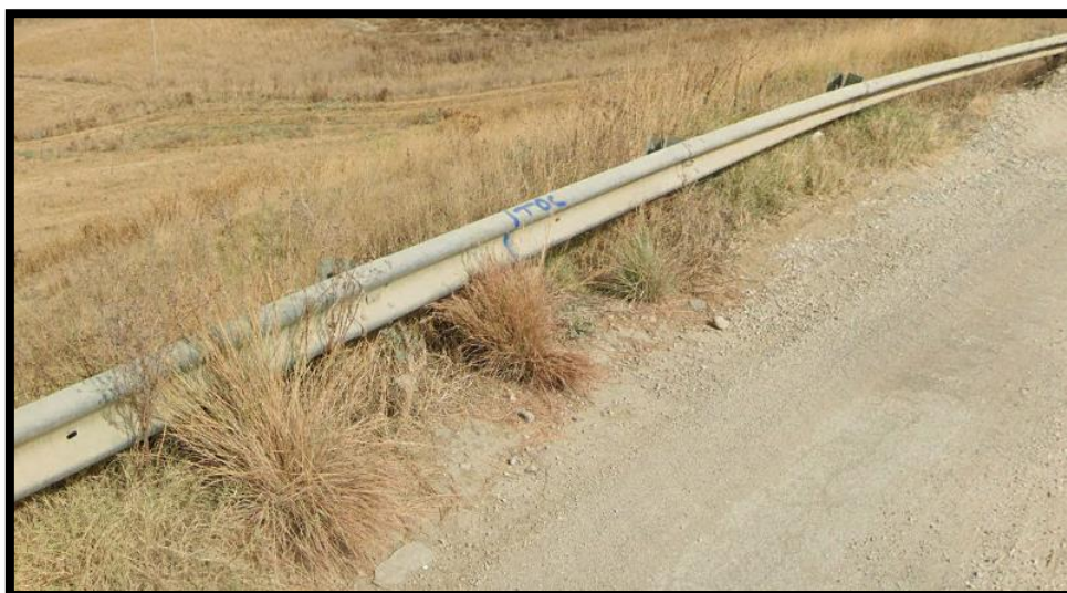
Figura 38 - foto dell'impluvio costituente l'interferenza "Int.38"
