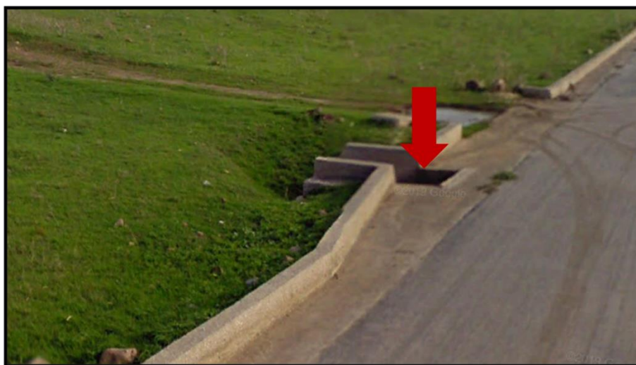
Figura 23 - foto dell'impluvio costituente l'interferenza "Int.23"
