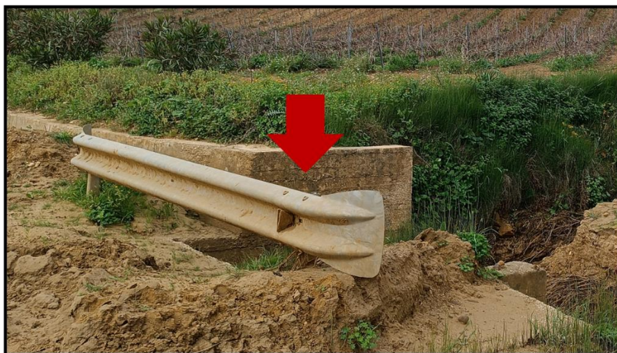
Figura 14 - foto dell'impluvio costituente l'interferenza "Int.14"
