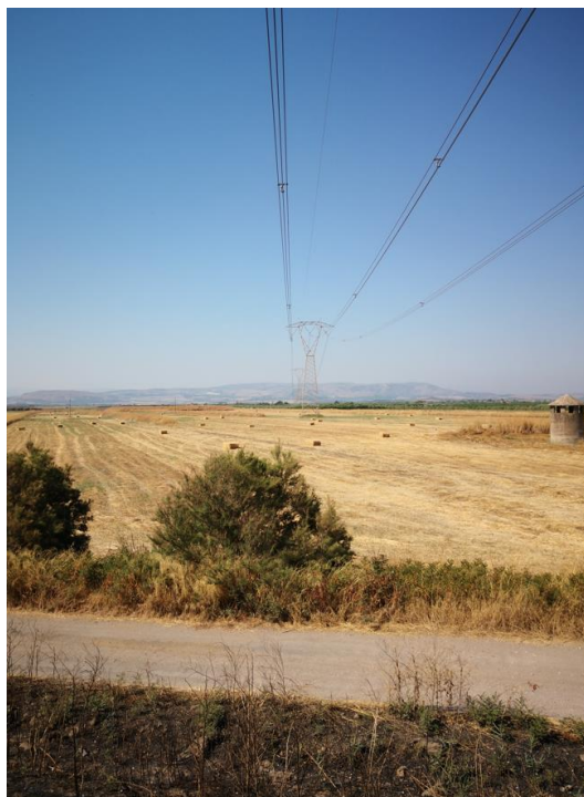
Figura 5-5 – Ripresa da sud lotto di terreno nuova SE
