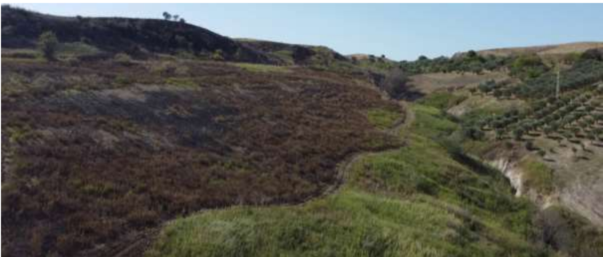
Immagine da drone della ditta esecutrice dei lavori dell'area di buffer oltre la pineta della collina di Gullo
