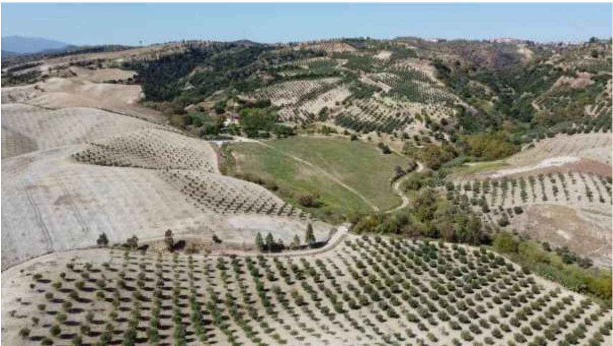
Immagine da drone della ditta esecutrice dei lavori dell'altura dove verrà installata la WTG 03
